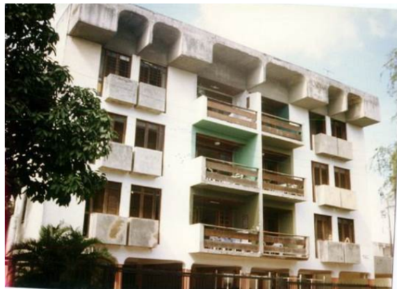
Figura 29 – Edifício residencial de três pavimentos mais os pilotis. Destaque em concreto aparente nas varandas e no coroamento. Fonte: Acervo Margarida Andrade
