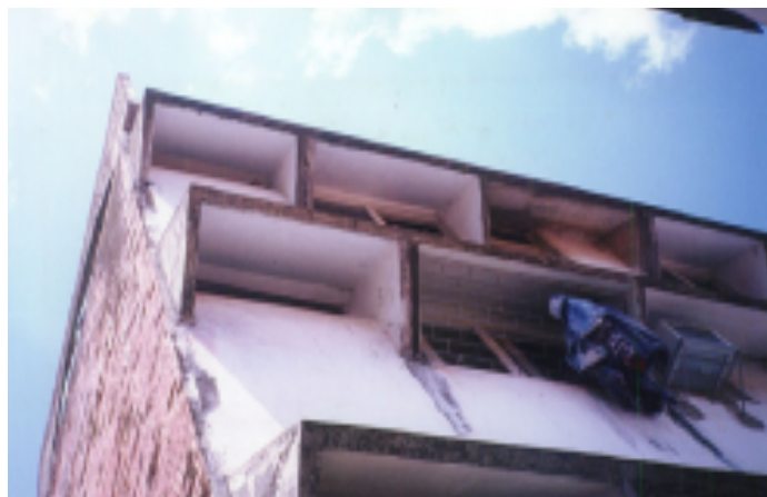
Figura 31 - Edifício Caramuru Arquiteto Rui Mamede Fonte: Acervo Margarida Andrade
