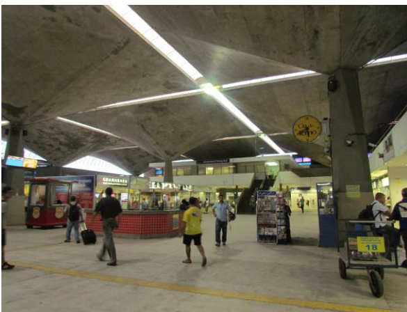
Figura 08 – Terminal Rodoviário Eng. João Thomé, 1973. Arq. Marrocos Aragão Fonte: Acervo Margarida Andrade
