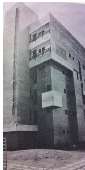
Figura 33 – Edifício Isaac Pontes, 1978 Arquiteto Regis Freire Destaca-se na fachada oeste a empena de concreto afastada do prédio. Fonte: Panorama da Arquitetura Cearense [...]1982:
