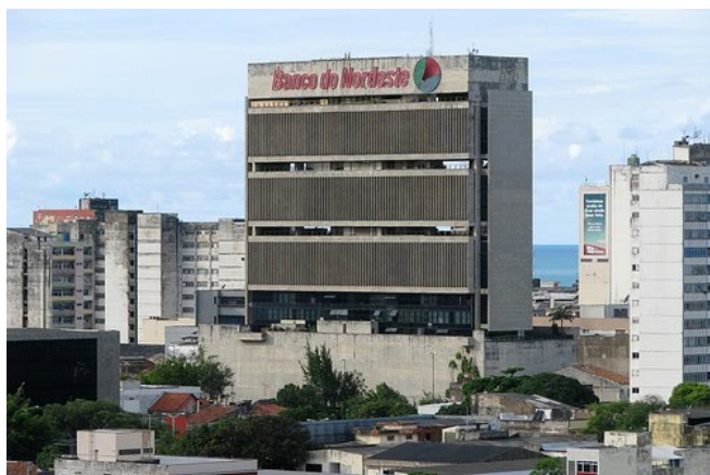
Figura 13 – Sede do BNB Arquitetos: Nelson Serra e Neves e outros Fonte: Site BNB
