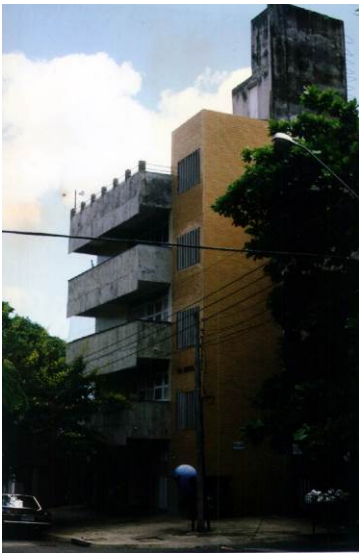
Figura 32 - Edifício Multifamiliar na Aldeota, 1980 Arquiteto João Carlos Bezerra Destaque para os balcões em concreto da fachada oeste, que também servem como quebra-sóis. Fonte: Acervo Margarida Andrade
