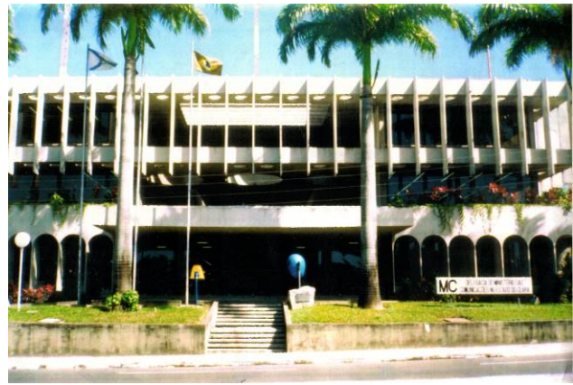
Figura 16- Notável o emprego do concreto aparente nos arcos do pavimento térreo e nos brises das fachadas.
