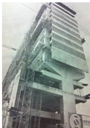
Figura 14 – Fachada oeste em construção do BNB, 1978 Arquitetos: Nelson Serra e Neves e outros Fonte: PANORAMA [...] 1982:138
