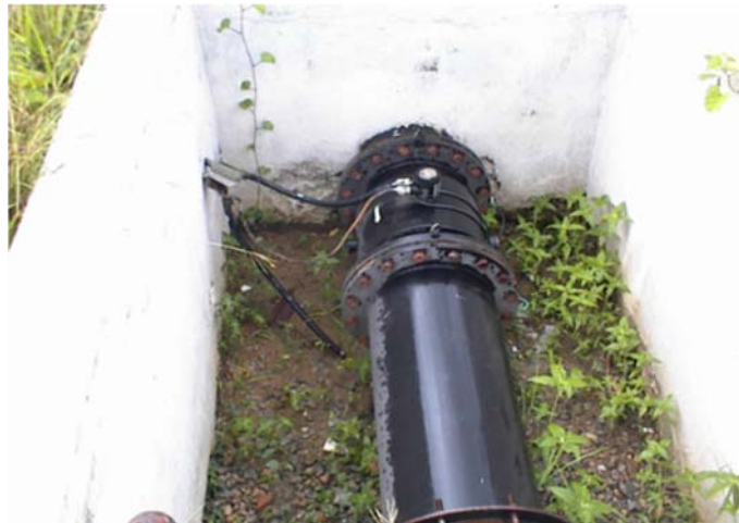
Figura 3.9. Medidor magnético de vazão
