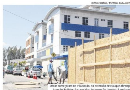
Obras começaram no Vila União, na extensão de rua que abrange a Associação Peter Pan e o Has. Intervenção terminará em janeiro
