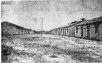
Rua de casas Tipo «A»
