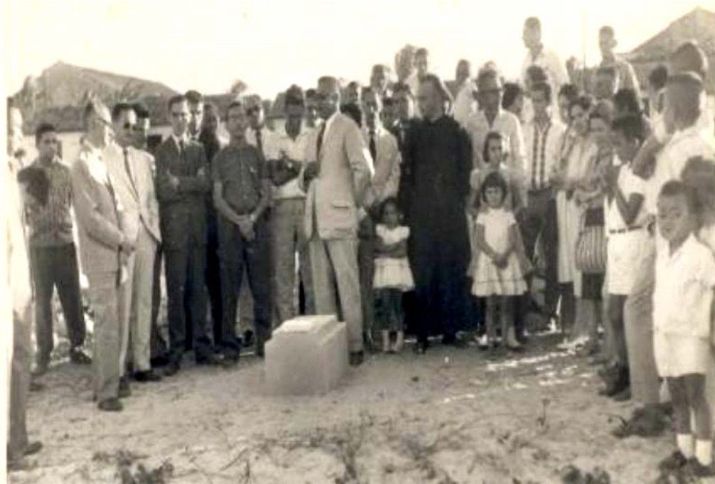
Figura 19 – Lançamento da pedra fundamental das casas da Vila Ferroviária Demóstenes Rockert, em frente à Oficina do Urubu, na Avenida Francisco Sá, bairro Álvaro Weyne, em Fortaleza (CE). Arquivo RVC/RFFSA e Arquivo Nirez.
