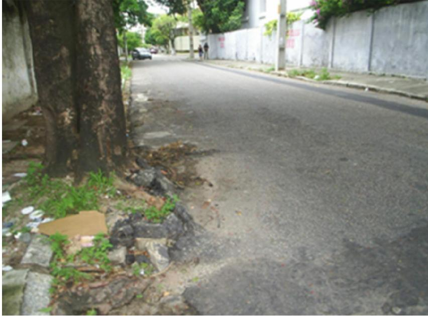
Figura 4.12 – A árvore na Aldeota com afloramento de raízes comprometendo a pista de rolamento (2007)
