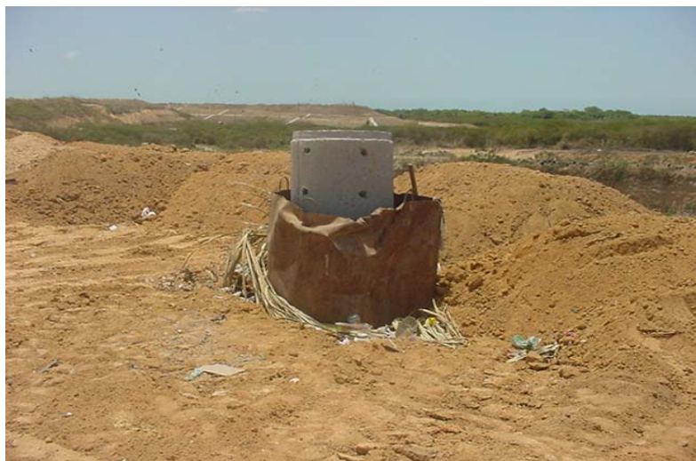
Figura A4 - Sistema de drenagem de gases do Aterro de Caucaia
