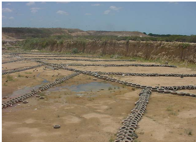
Figura A5 - Sistema de drenagem do chorume do Aterro Sanitário de Caucaia
