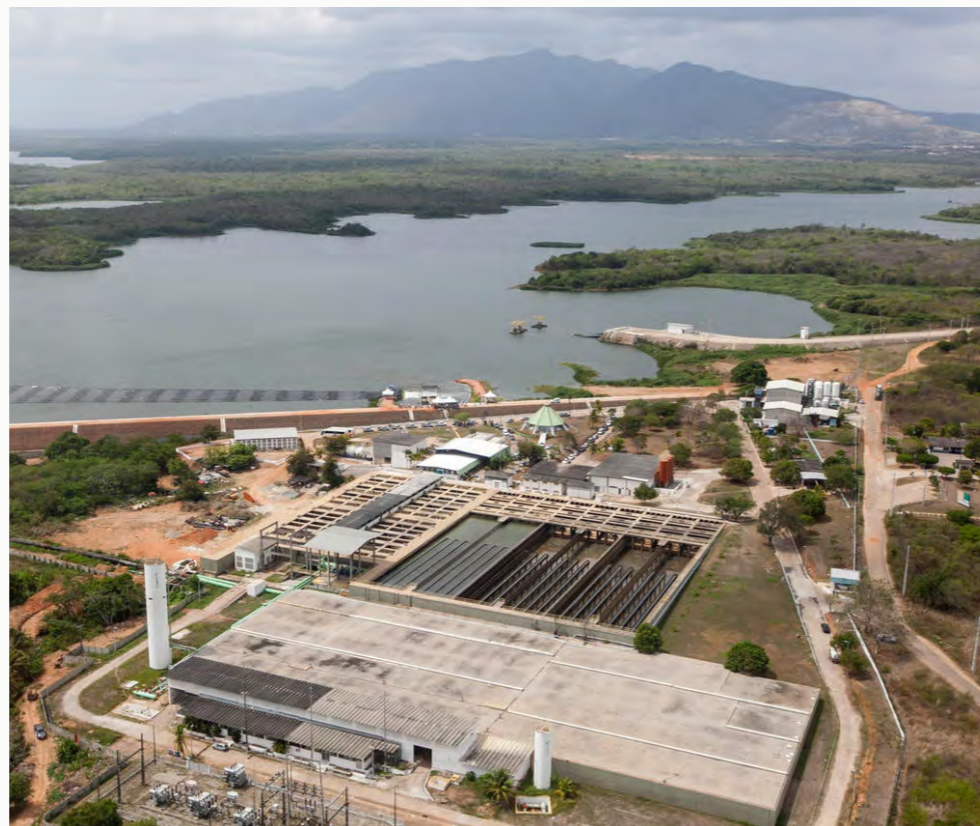
Estação de Tratamento ETA Gavião/ Fonte: Cagece, 2013
