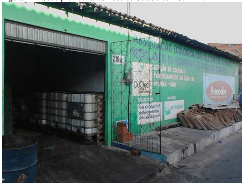
Figura 22 – Sede provisória da Rede de Catadores – Serrinha
