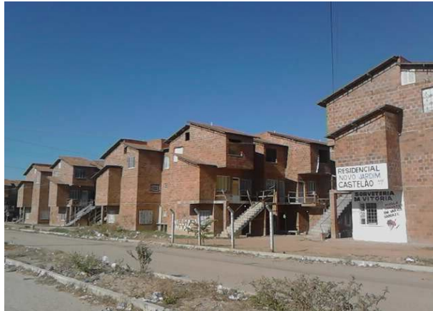
Figura 5 – Residências dos catadores de resíduos sólidos – Programa Minha Casa, Minha Vida – bairro Jangurussu
