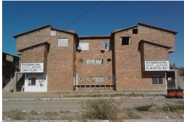
Figura 4 – Residências dos catadores de resíduos sólidos – Programa Minha Casa, Minha Vida – bairro Jangurussu
