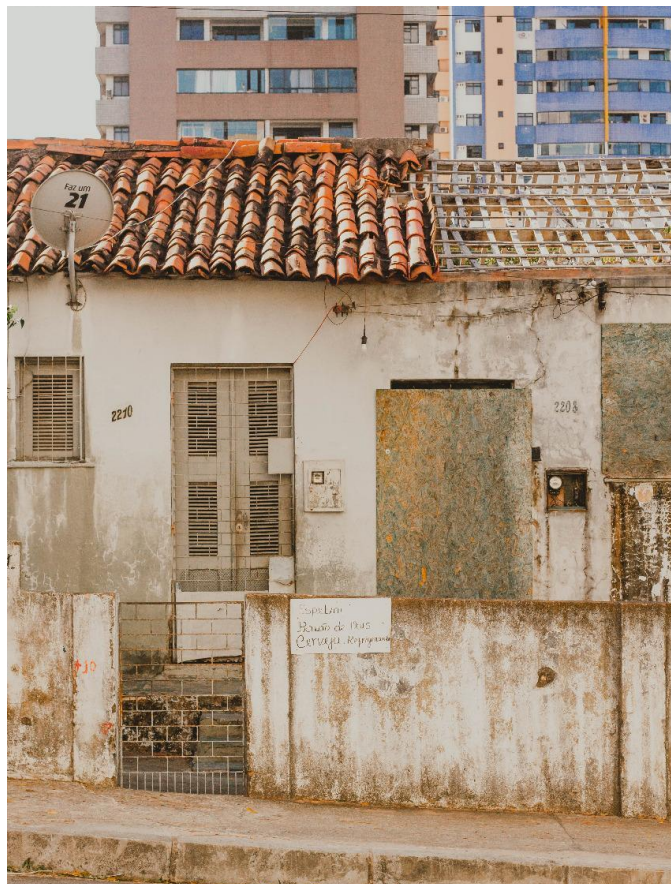
Figura 15: Casas parcialmente demolidas da Rua Tibúrcio Cavalcante. Fonte: Daniela Silveira, 2020.
