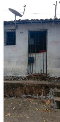
5 CALÇADA ELEVADA FONTE: IPLANFOR
