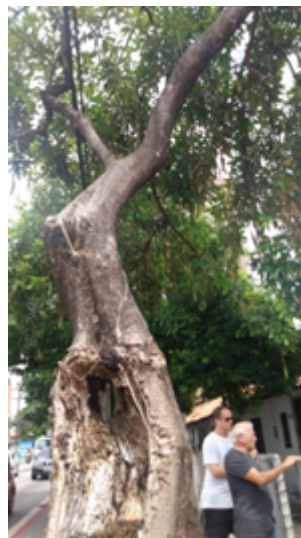
Árvore de Sombreiro severamente comprometida com brocas
