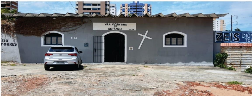
1 FACHADA DA CAPELA FONTE: IPLANFOR
