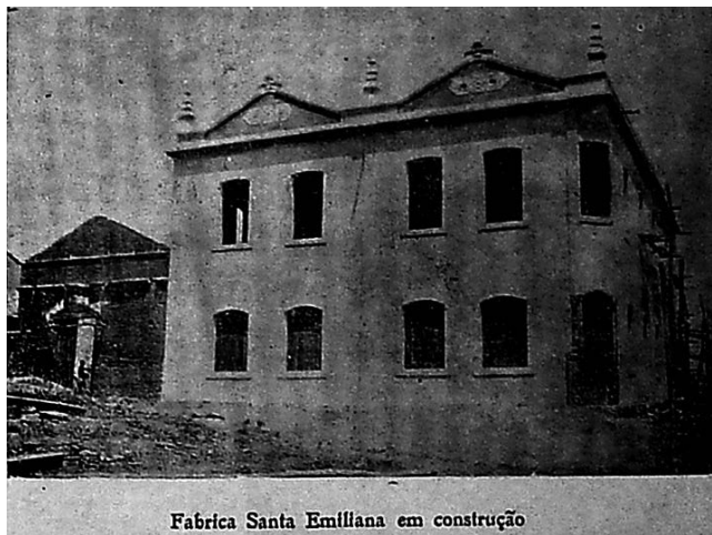
Fábrica Santa Emiliania em construção
