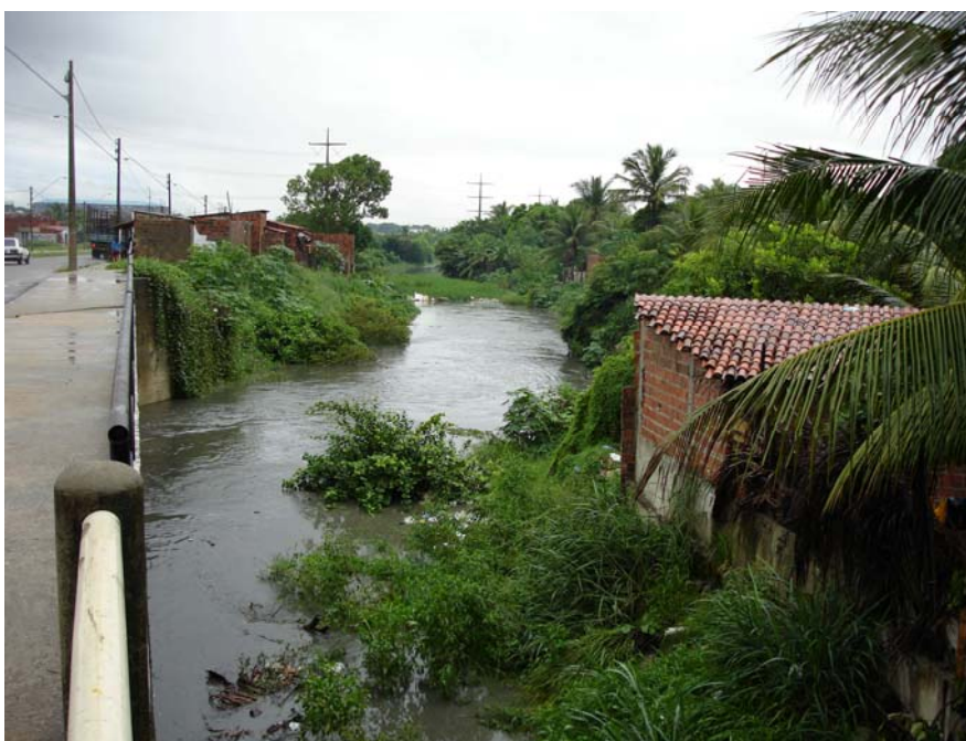
Figura 31: Área de inundação ocupada e residências expostas a riscos.
