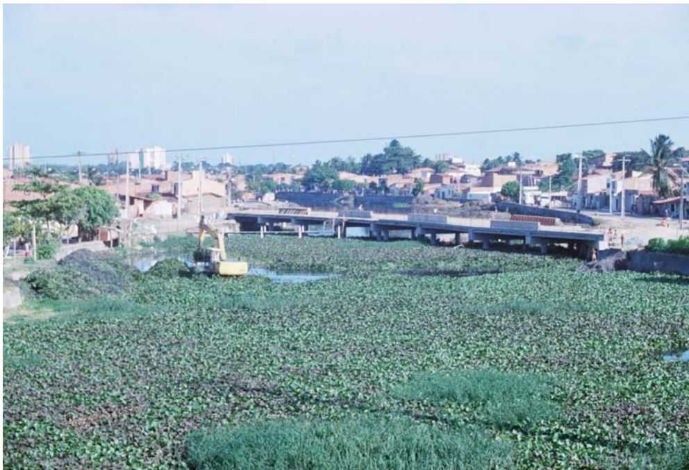
Figura 48: Vista parcial mostrando o elevado nível de eutrofização do Canal do Tauape. Notar a ocupação irregular pelas margens e obras de limpeza do canal.
