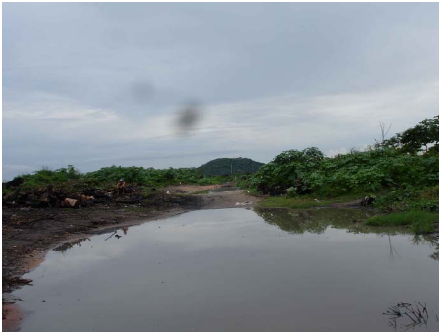
Figura 38: Péssimas condições da estrada de acesso às lavras clandestinas. Notar ao fundo a adutora e estação elevatória do Ancuri.
