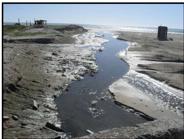
Figura 109. Esgoto a céu aberto na comunidade Serviluz, no bairro Cais do Porto. Fortaleza, 2011. Foto: CARUSO JR (2011).
