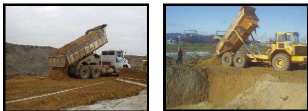
Figura 130. Exemplos de deposição de material de aterro. Fotos: CARUSO JR (2005).
