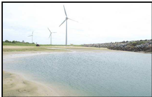
Figura 31. Laguna temporária formada na Praia Mansa por intrusão da água oceânica por entre as rochas do molhe. Foto: CARUSO JR. (2011).
