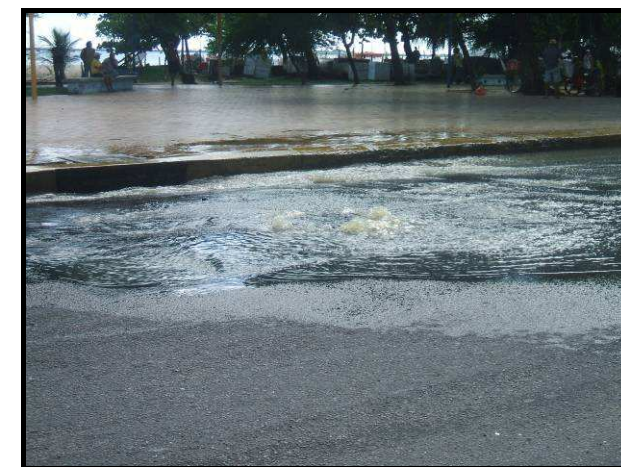
Figura 108. Problemas na tubulação de esgoto na avenida Beira Mar, bairro Mucuripe. Foto: CARUSO JR (2011).
