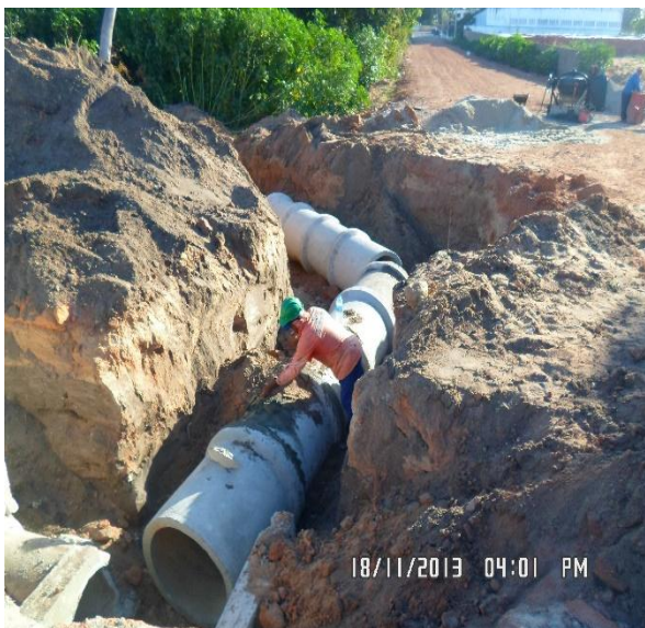
Fig. 2.3.1.7 – Execução de drenagem com tubulação de concreto de diâmetro de 60cm no cruzamento da Av. Walter Bezerra de Sá com Rua Gustavo Augusto.
