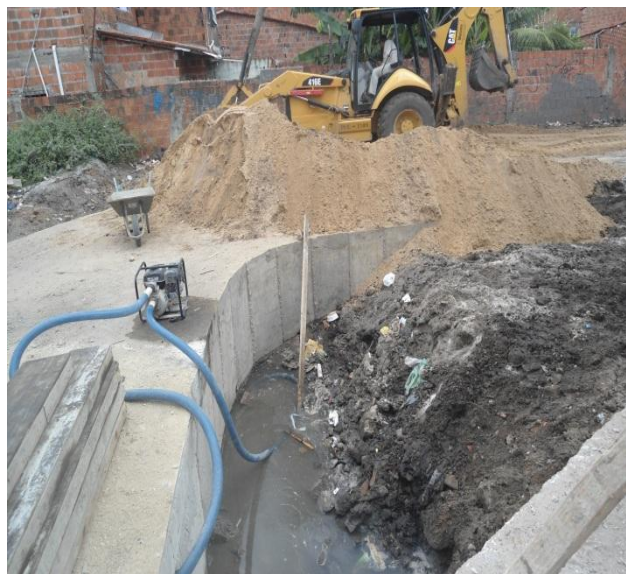
Figura 2.4.1.2 – Galeria de seção 2(170 x 100) cm – Reaterro das laterais da galeria com material adquirido.
