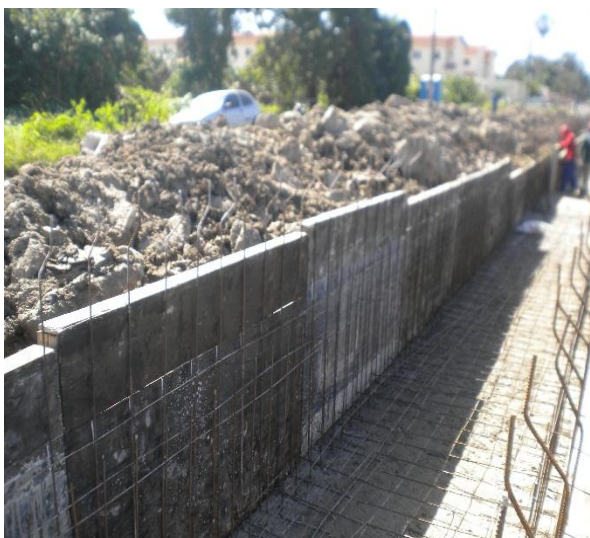
Figura 3.7.1.5 – Armação da ferragem para execução da galeria celular (150x80) cm na Avenida Luiz Montenegro, estaca 20 a 23.
