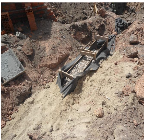
Figura 3.3.1.7 – Trincheira drenante sendo executada na Rua Senhorinha Saraiva, entre estacas 5 e 6.
