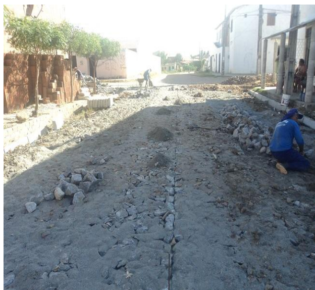
Figura 3.7.1.8 – Pavimentação em pedra tosca em execução na Rua SDO 05.
