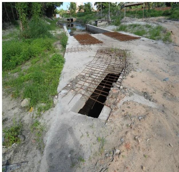
Figura 3.3.1.2 – Canal à céu aberto – estaca 12.
