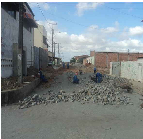
Figura 3.7.1.7 – Pavimentação em pedra tosca em execução na Rua SDO 02.
