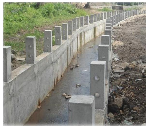
Figura 3.6.1.4 – Execução dos pilares do guarda corpo
