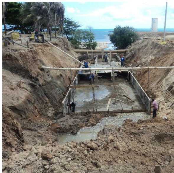
Figura 2.1.1.2 - Execução da galeria de seção 3(230x110) cm no trecho entre as estacas 24 e 23.
