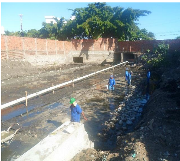
Figura 2.2.1.5 – Execução do colchão de areia grossa, entre estacas 34+10,00m a 35+10,00m
