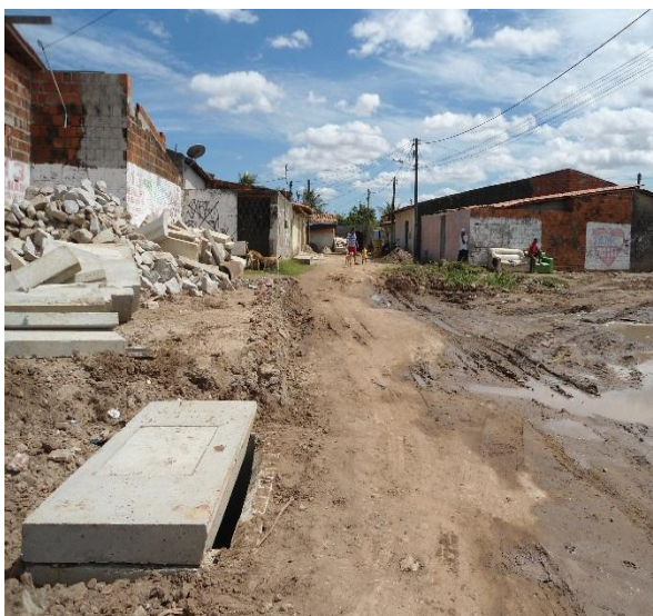
Figura 3.5.1.5 – Bocas de lobo executadas na Travessa Ismael Silva.
