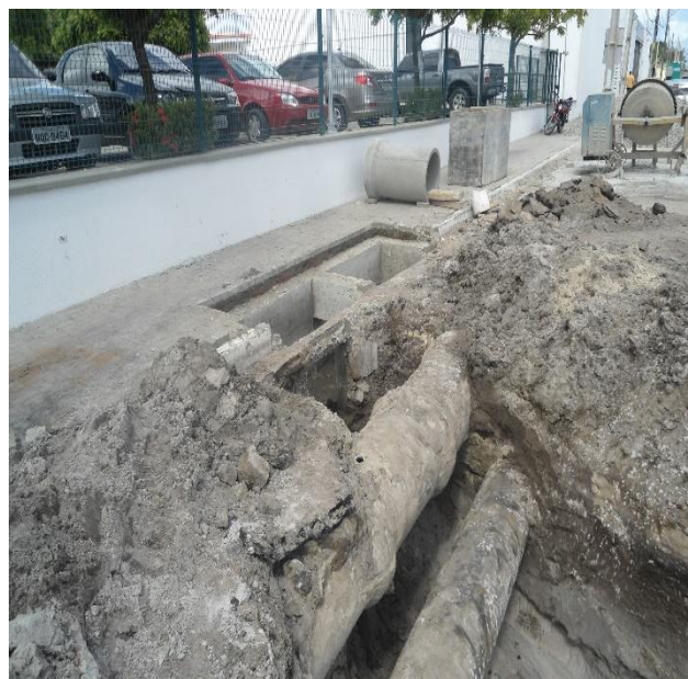
Figura 3.3.1.6 – Bocas de lobo executadas na Rua Ulisses Bezerra, estaca 4.
