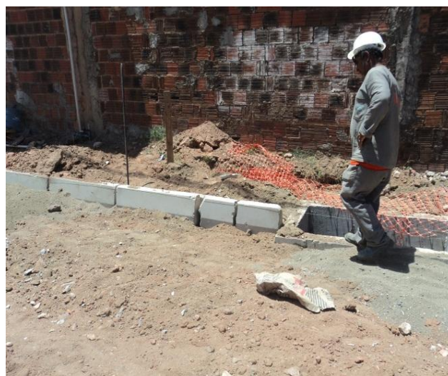
Figura 3.1.1.4 – Serviços restantes de fechamento de bocas de lobos e postos de visitas.
