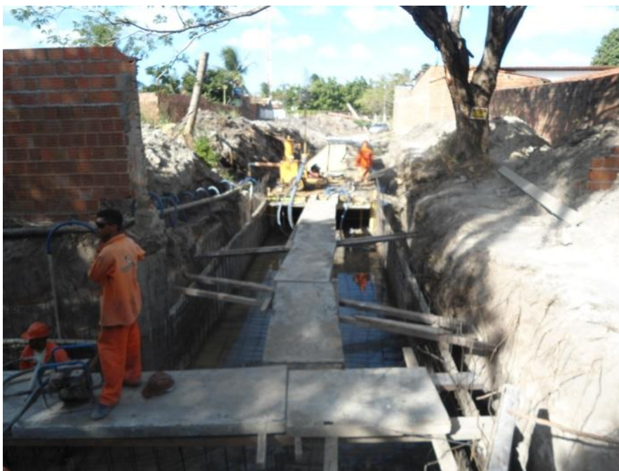
Figura 21: Canal desafio jovem – Concretagem da laje inferior
