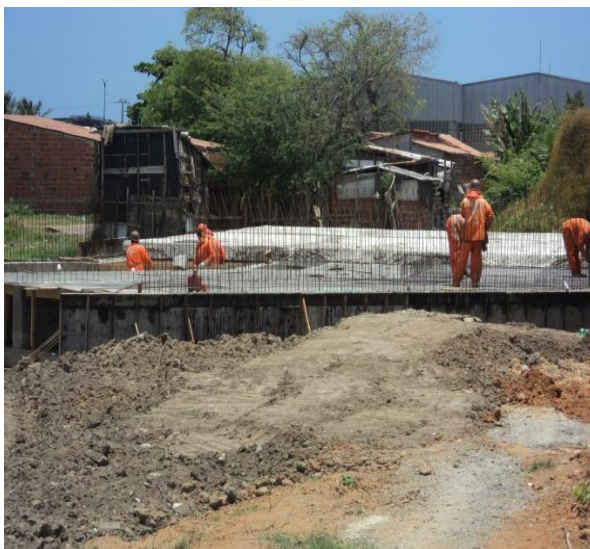
Figura 3.2.1.1 – Rua SDO – Execução da Laje da galeria celular 3(350x100) cm.
