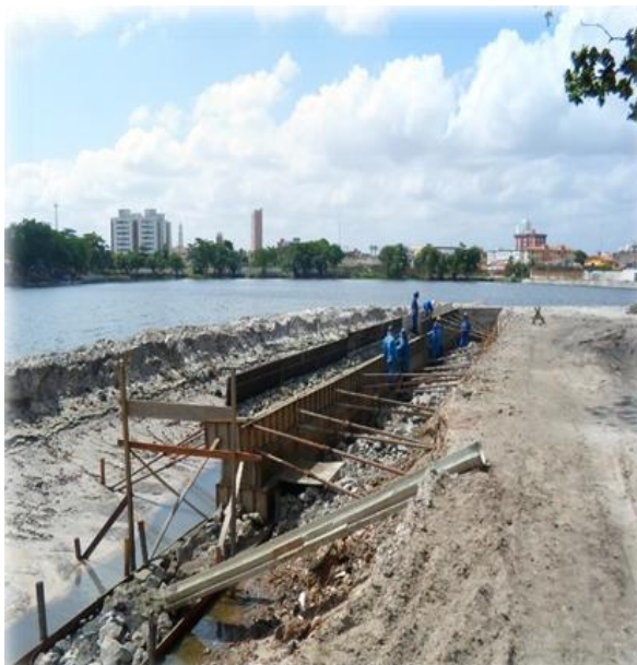
Figura 2.5.1.3 - Construção da mureta de contenção das margens
