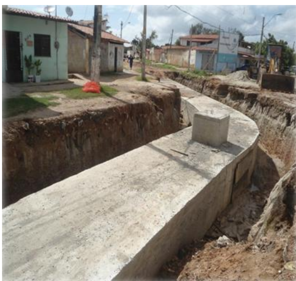
Figura 3.4.1.7 - Execução da galeria celular na av. Evilásio Miranda
