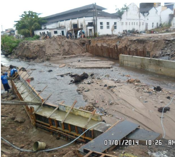
Figura 2.2.1.3 – Canal executado entre as estacas 45+5,00m e 46.
