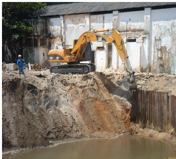
Figura 2.2.1.2 – Escavadeira Hidráulica realizando o escoramento com pranchas metálicas.
