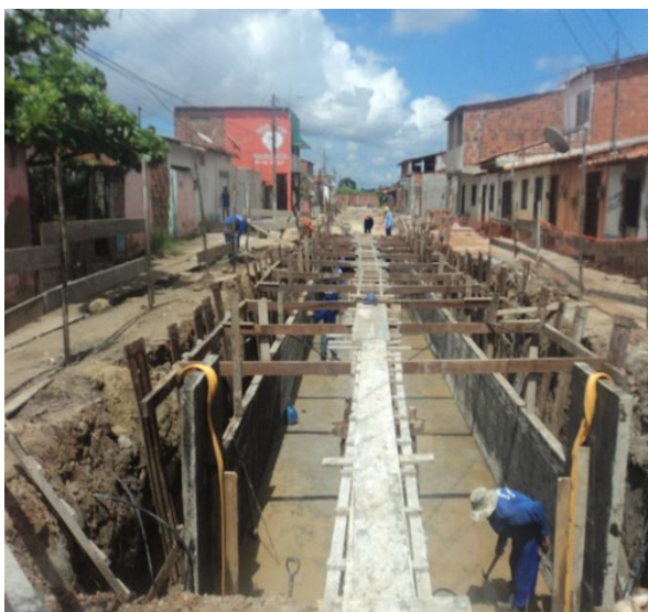
Fig. 3.8.1.7 – Montagem de armadura das paredes da galeria celular de concreto armado, seção (300 x 100) cm, entre as estacas 5+2,00m e 6+10,00m na Rua São Basílio.
