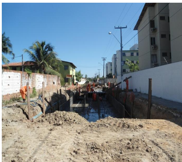
Figura 3.2.1.4 – Rua Tibúrcio Pereira – Em construção da galeria celular 3(200x100) cm – Estaca 6.
