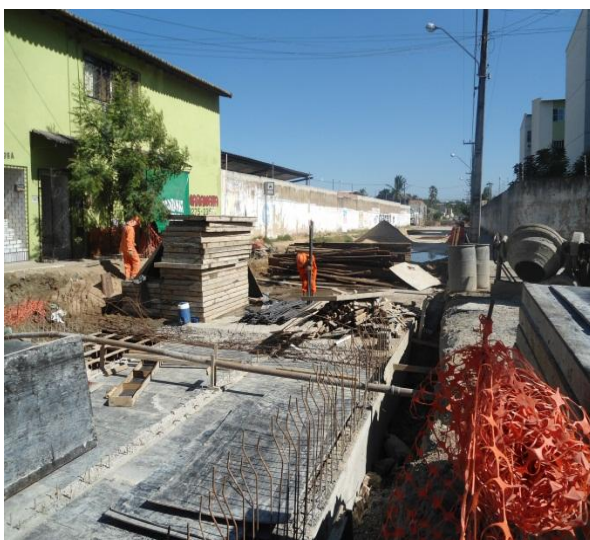
Figura 3.2.1.3 – Rua Tibúrcio Pereira – Trecho executado da galeria celular 3(200x100) cm
