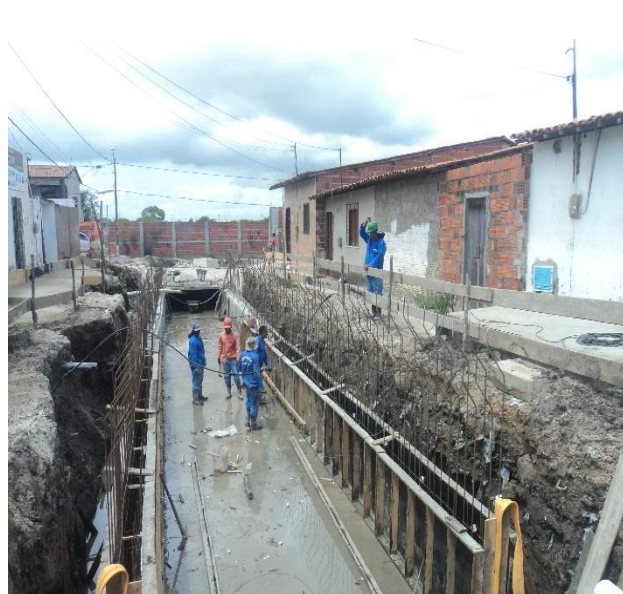
Figura 3.8.1.4 – Posicionamento de formas e armaduras, para galeria celular de concreto armado, seção (300 x 100) cm, entre estacas 1 e 2, Rua São Basílio.
