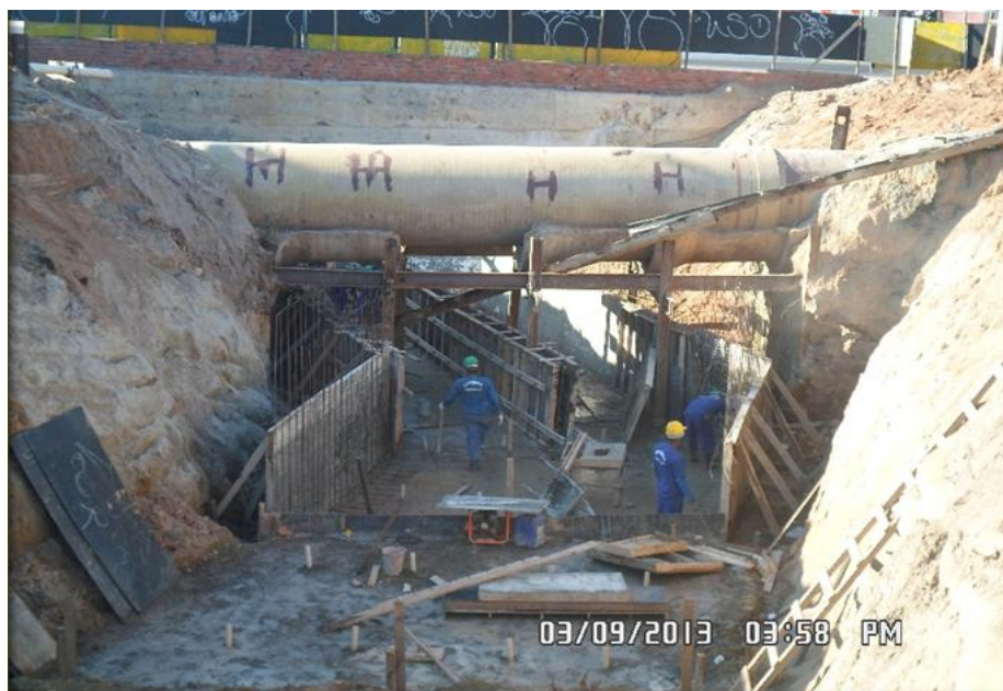
Figura 18: Início da obra de macrodrenagem do riacho Jacarecanga
