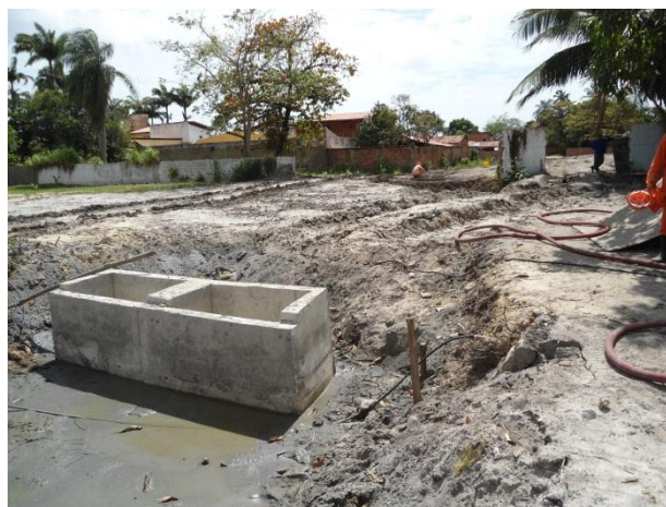
Figura 2.4.1.6 – Boca de lobo executada na estaca 6.
