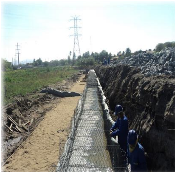
Fig. 2.5.1.5 – Execução do gabião tipo caixa nas margens do riacho
