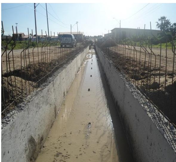
Figura 3.7.1.3 – Paredes e laje de fundo da galeria celular (150x80) cm na Avenida Luiz Montenegro, estaca 21 a 27.
