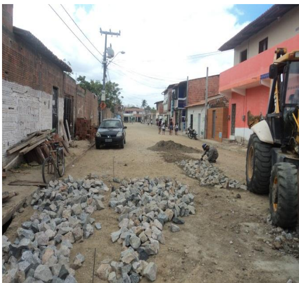
Figura 3.1.1.5 – Rua Itatiaia – Finalização da reforma de pavimento em pedra tosca.
