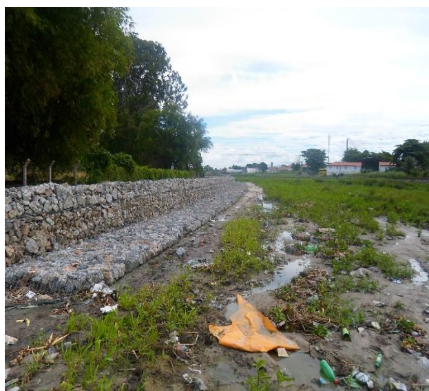
Figura 2.5.1.10 – Gabião tipo caixa executado entre as estacas 58 e 61 na margem esquerda.
