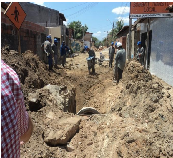
Figura 3.1.1.1 – Rua Tatiana – assentamento de tubos próximo a estaca 10.
