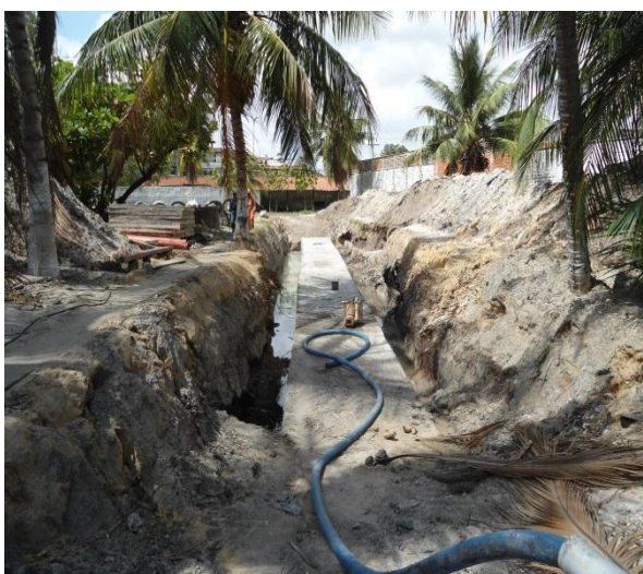
Figura 2.4.1.7 – Galeria de seção (180 x 100) cm executada entre as estacas 6 e 3.
