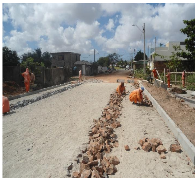
Figura 3.3.1.8 – Pavimentação em pedra tosca sendo executada no trecho da Rua Cezídio Albuquerque, entre as estacas 9 + 10,00m e 10 + 5,00m.
