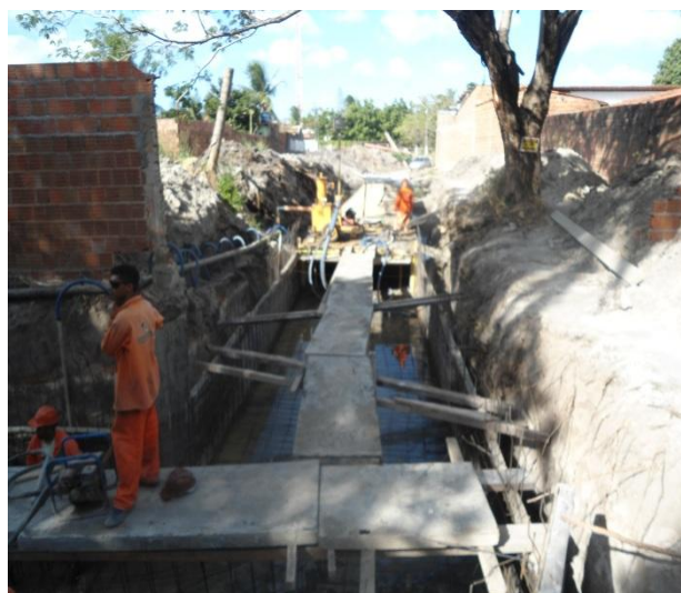
Figura 2.4.1.4 – Canal desafio jovem Est. 16 e 17 – Concretagem da laje inferior.
