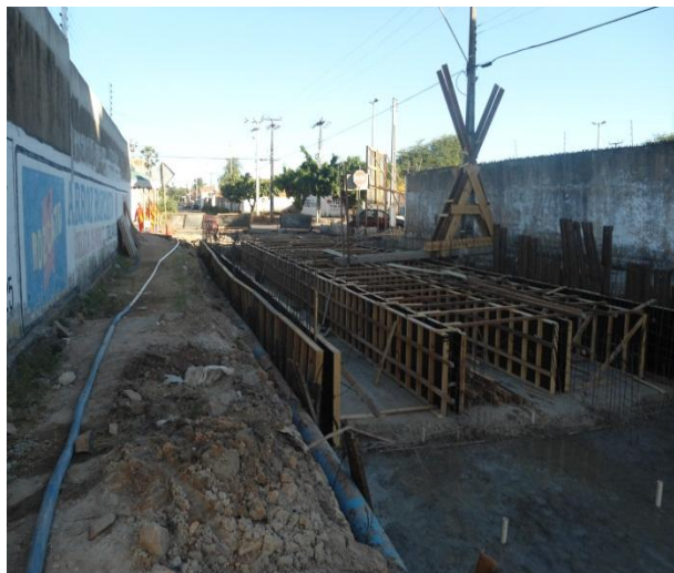
Figura 3.2.1.2 – Rua Tibúrcio Pereira – construção da galeria celular 3(200x100) cm
