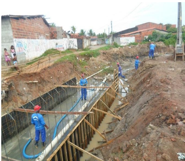
Figura 3.5.1.1 – Montagem de ferragem da galeria de seção (300x120) cm no trecho entre as estacas 6 a 6+15,00m na Rua Ismael Silva.
