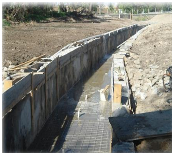
Figura 3.6.1.2 – Execução de alvenaria de pedra do canal
