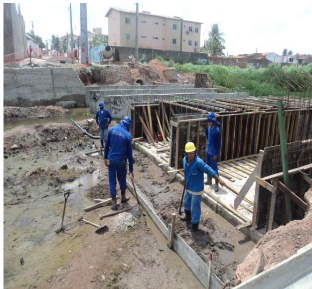
Figura 2.5.1.4 – Execução do bueiro da Rua Rui Monte de seção 5(340x 140) cm.
