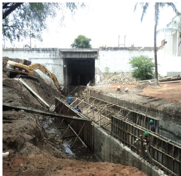
Figura 2.1.1.4 - Montagem da fôrma das paredes da galeria de seção 2(230x150) cm.
