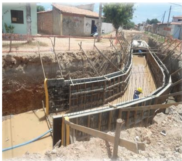
Figura 3.4.1.6 - Execução da galeria celular na av. Evilásio Miranda
