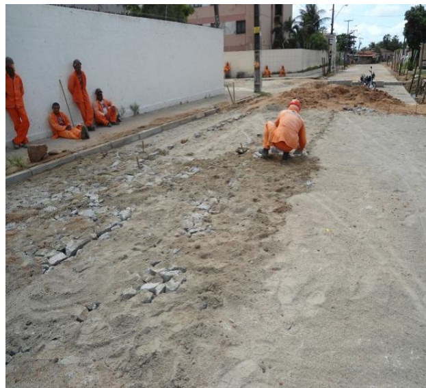
Figura 3.2.1.8 - Rua Tibúrcio Pereira –execução da pavimentação – Estaca 8.
