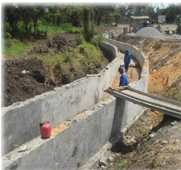
Figura 3.6.1.3 – Execução de alvenaria de pedra do canal
