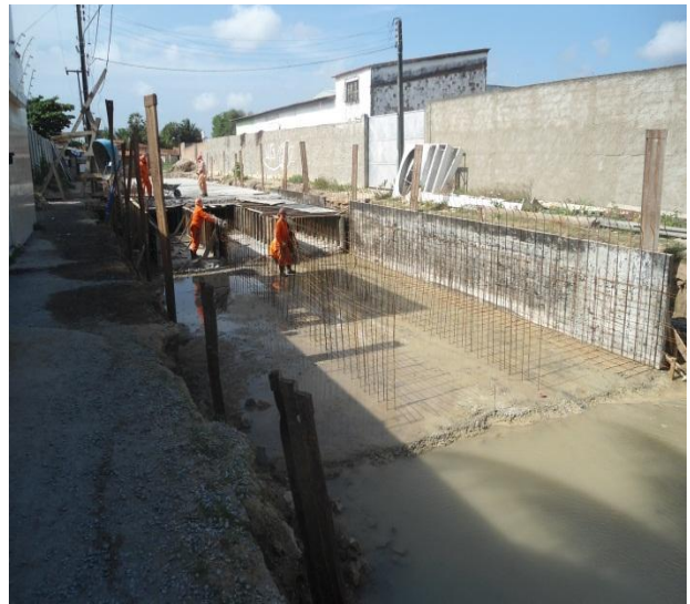
Figura 3.2.1.6 – Rua Tibúrcio Pereira – Galeria executada – Estaca 10.
