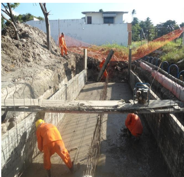
Figura 2.4.1.3 – Galeria de seção 2(150 x 100) - Rebaixamento do lençol freático e execução da armadura entre as estacas 19 e 18.
