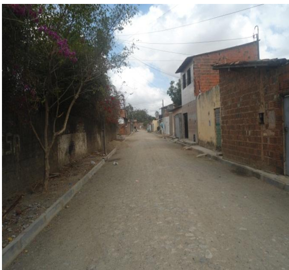
Fig. 3.1.1.7 – Rua Tatiana Executada.
