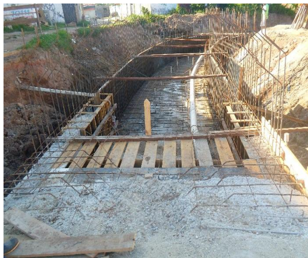
Figura 3.5.1.2 – Execução de galeria de seção (300x120) cm no trecho entre as estacas 5 e 6+15,00m na Rua Ismael Silva.
