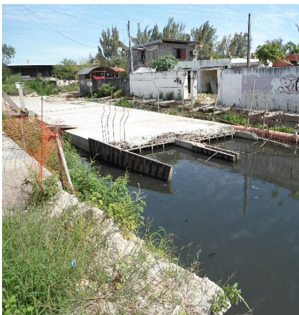
Figura 3.3.1.5 – galeria 2(300x130) cm, estaca 16 em execução.
