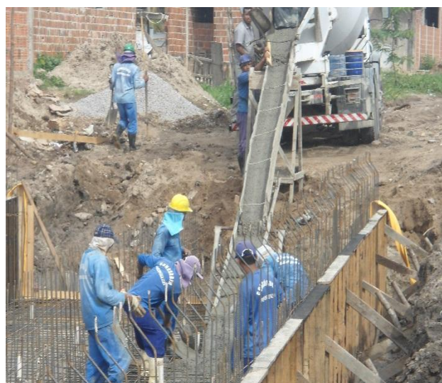
Figura 3.8.1.2 – Concretagem da laje inferior, galeria celular de concreto armado, seção 2(220 x 100) cm, entre as estacas 4 e 5+2,00m da Rua Umarizeira.
