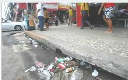
Imagens de Drenagem Cidade
