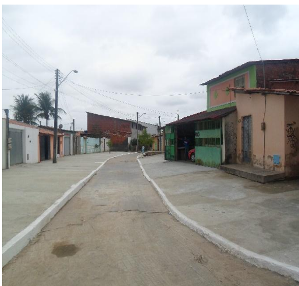
Figura 3.5.1.7 – Passeios executados na continuação da Rua 02, entre Rua Benedito Alves e Rua Coqueiro.
