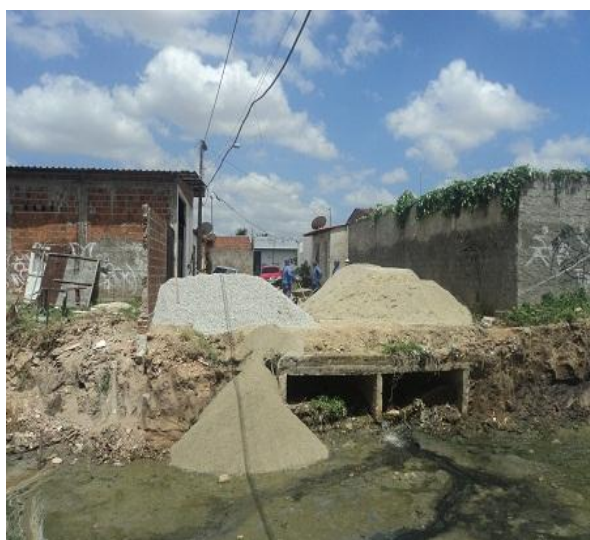
Figura 3.8.1.1 – Material presente na obra para execução de concreto de regularização
