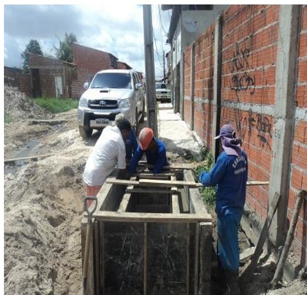
Figura 3.8.1.6 – Boca de lobo em execução, próximo à estaca 6, Rua Umarizeiras.
