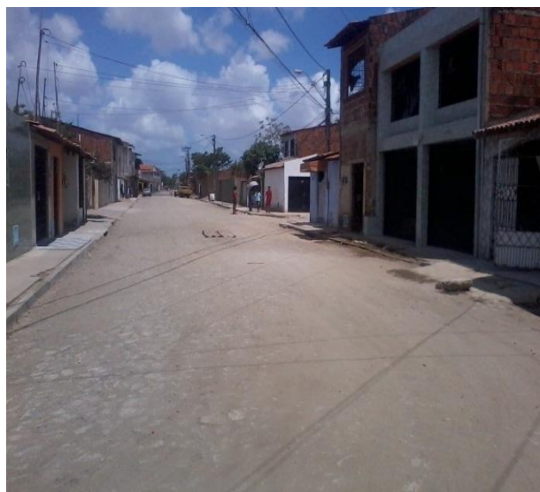
Figura 3.1.1.6 – Serviços restantes de fechamento de bocas de lobos e postos de visitas.
