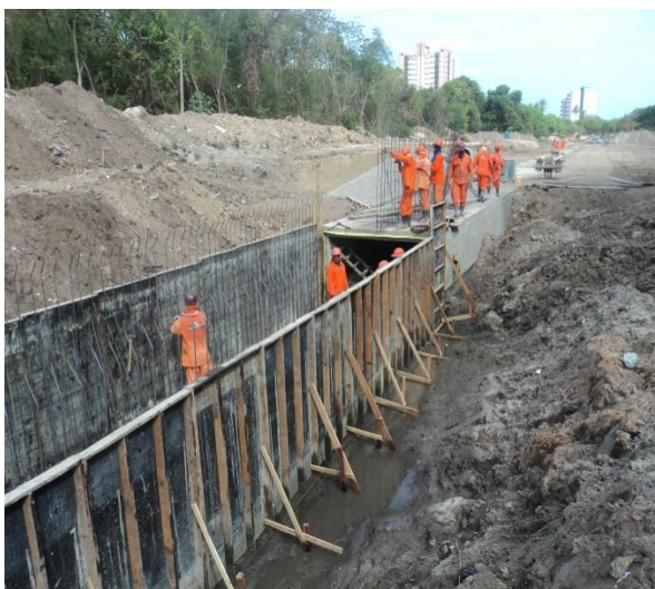
Figura 2.3.1.5 – Junção da galeria celular da Av. Walter Bezerra de Sá de seção (260 x 140) cm com o bueiro de mesma seção na Av. Rogaciano Leite.
