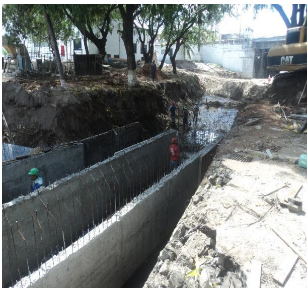
Figura 2.1.1.3 - Trecho de galeria de seção 2(230x150) cm com paredes executadas.
