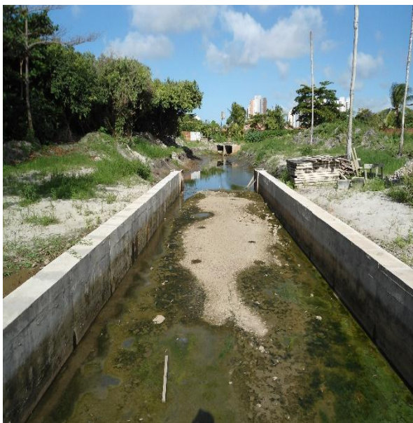
Figura 3.3.1.3 – Canal à céu aberto entre as estacas 9 e 12.
