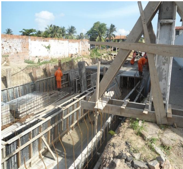
Figura 3.2.1.5 – Rua Tibúrcio Pereira – Trecho executado da galeria celular 3(200x100) cm - estaca 9.
