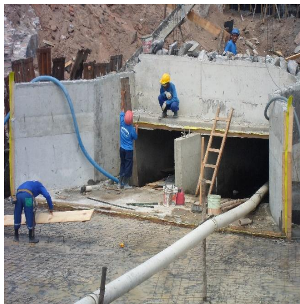
Figura 2.1.1.6 – Primeira etapa da obra do Riacho do Jacarecanga concluída.
