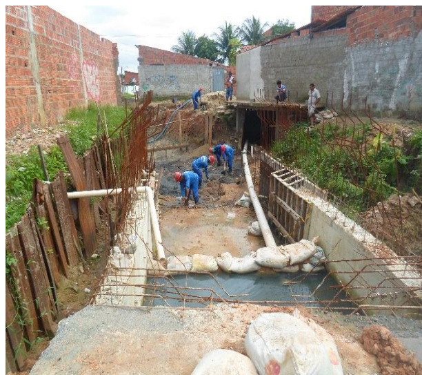
Figura 3.5.1.6 – Execução da galeria de seção (300x120) cm no trecho entre as estacas 2 e 2+10,00m.
