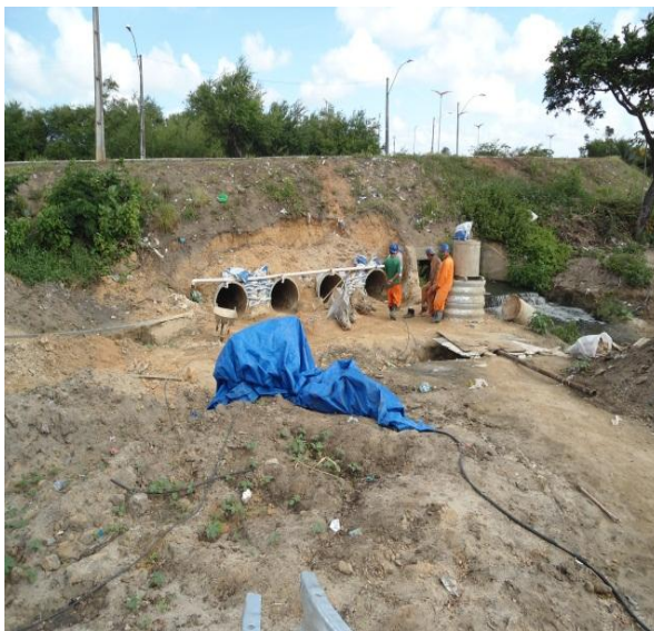
Figura 3.2.1.7 – Travessia da alça de acesso à avenida Paulino Rocha – Colocação de tubos armcos.
