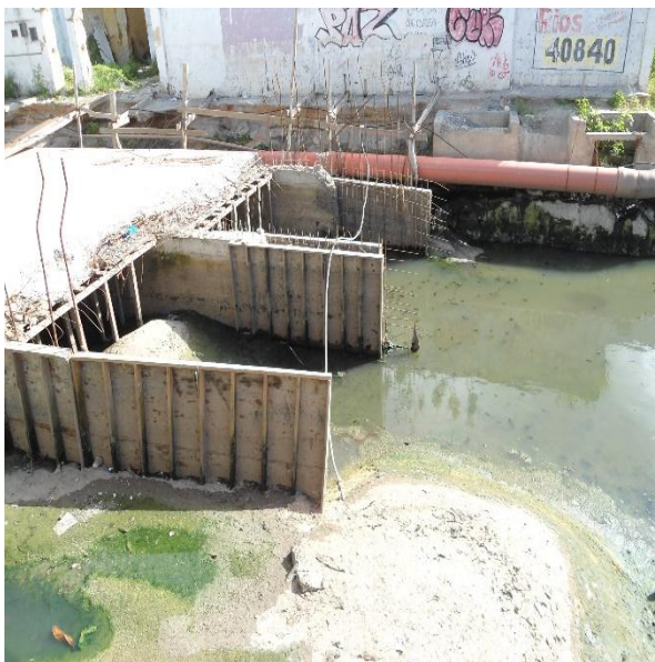
Figura 3.3.1.1 – Galeria 2(3,00x1,30) m executada até à estaca 16.
