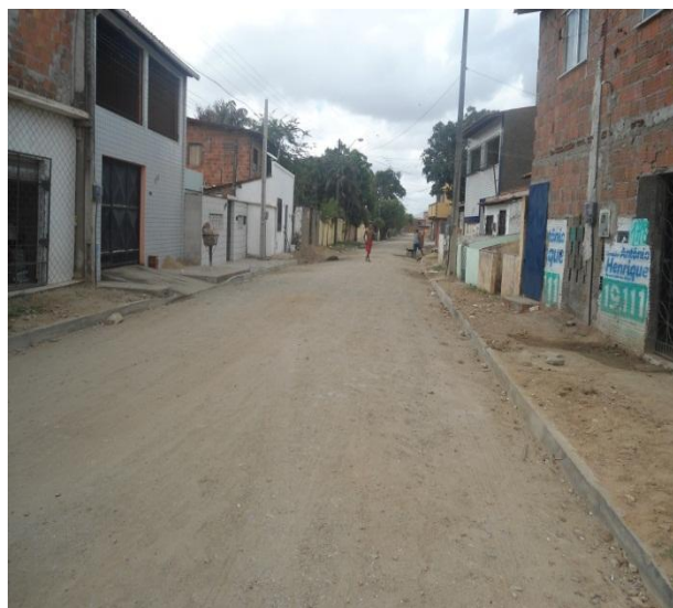
Fig. 3.1.1.8 – Rua Itajaí Executada.
