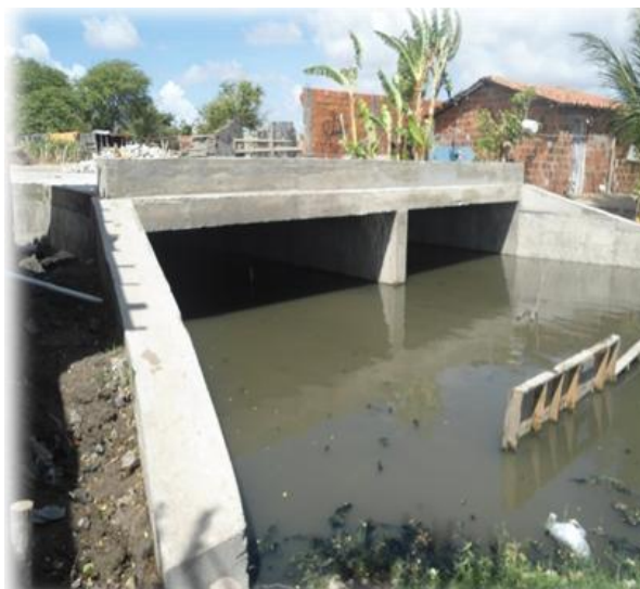
Figura 3.4.1.3 - Saída da galeria do lançamento da lagoa
