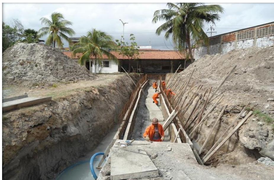
Figura 20: Execução de galeria no Canal
