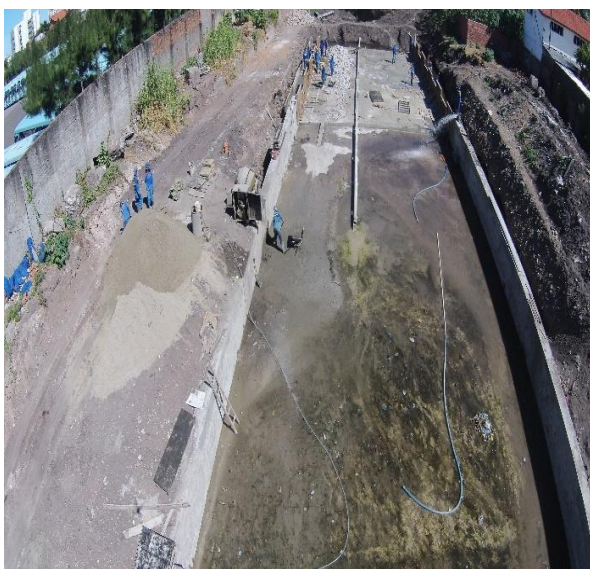
Figura 2.2.1.7 - Foto aérea da execução
