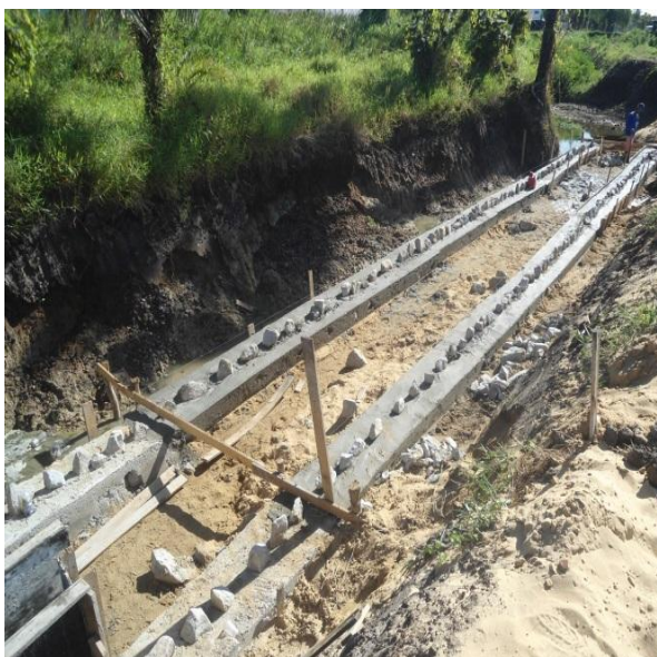
Figura 3.6.1.5 – Colchão de areia e baldrame em execução, entre estacas 30 e 31.
