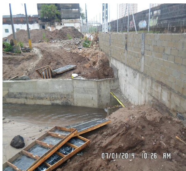
Figura 2.1.1.8 – Obra do Riacho Jacarecanga 1ª Etapa concluída.
