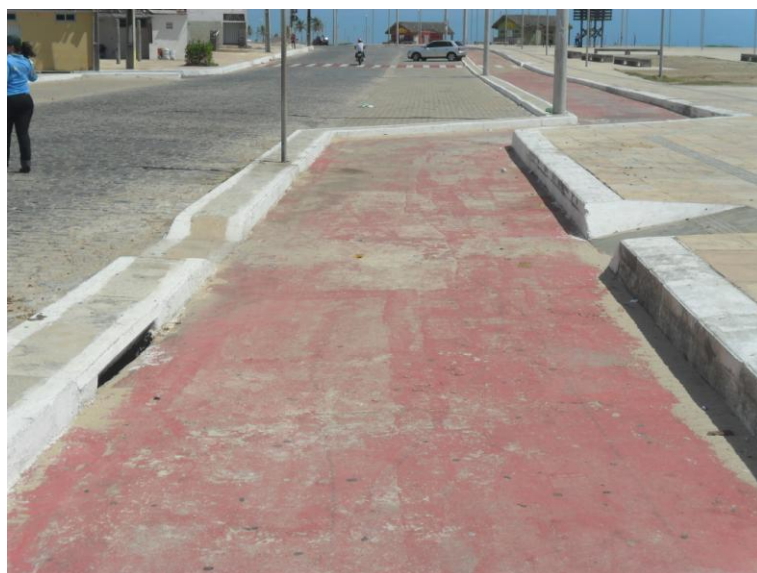
Figura 16: Drenagem na Orla da Cidade
