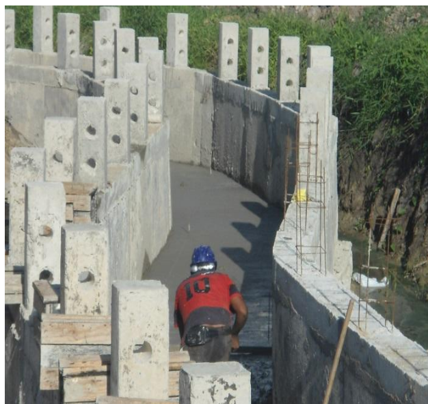
Figura 3.6.1.6 – Laje inferior sendo executada no canal à céu aberto de seção (180x100) cm, entre estacas 334 e 34.
