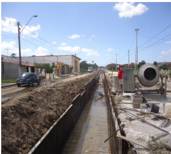
Figura 3.7.1.1 – Execução da galeria celular (150x80) cm na Avenida Luiz Montenegro, estaca 21 a 22.
