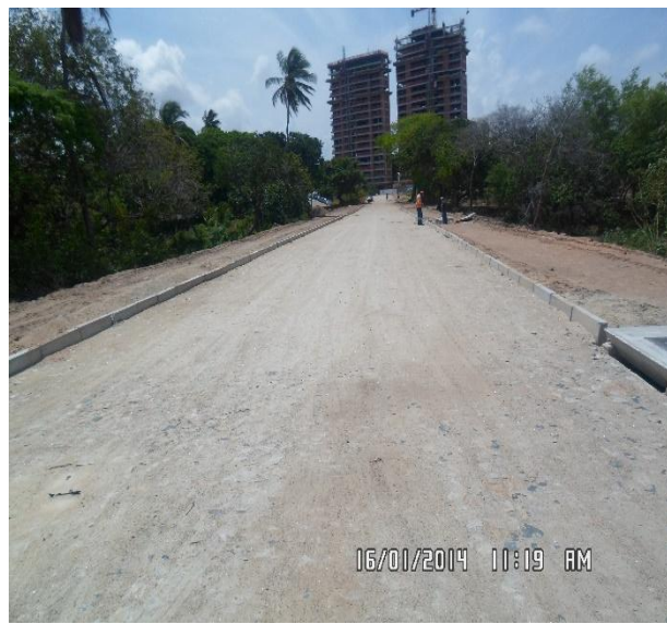
Fig. 2.3.1.8 – Pavimentação em pedra tosca na Rua Bolivar Pinto Bandeira concluída.
