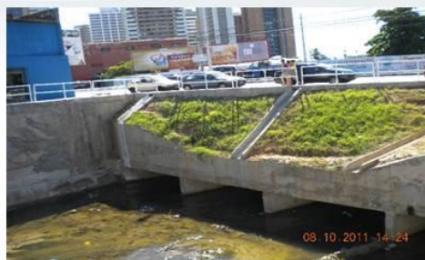
Av. Abolição - Bueiro
