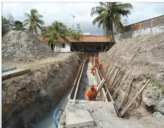
Início da obra de macrodrenagem do riacho Jacarecanga
