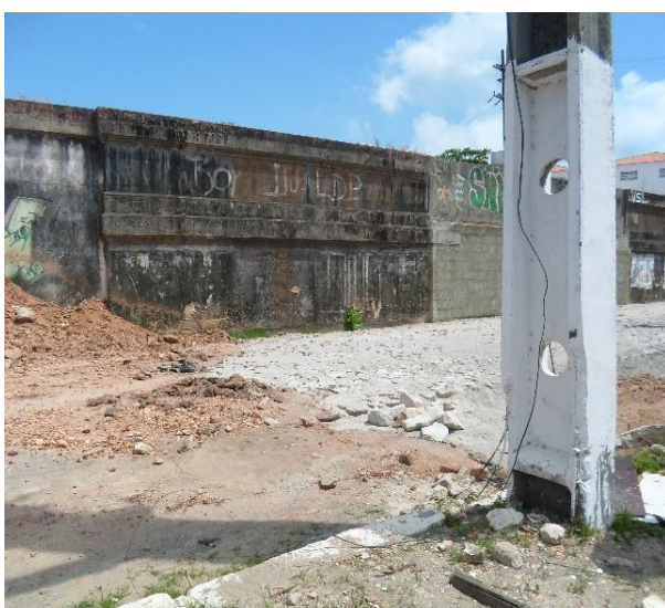
Figura 2.1.1.7 – Revestimento em pedra tosca sendo executada na Rua Maria Luiza.
