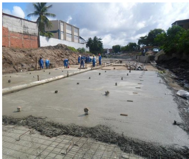
Figura 2.2.1.6 – Concretagem da laje inferior do canal de seção (1400x150) cm, entre as estacas 22+10,00m e 24+10,00m
