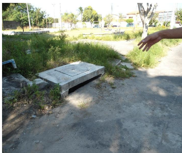
Figura 2.4.1.8 – Boca de lobo executada entre as estacas 21 e 22.
