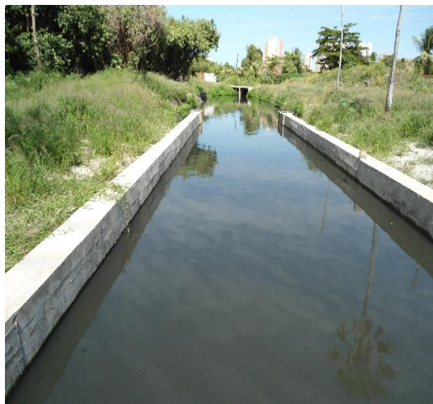
Figura 3.3.1.4 – Canal à céu aberto que terá continuidade até a ligação com a outra galeria, entre as estacas 9 e 12.
