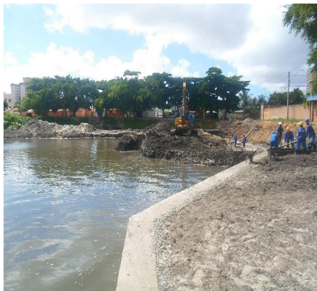
Fig. 2.5.1.6 – Execução do muro em alvenaria de pedra próximo à Rua Aristides Barreto Neto.
