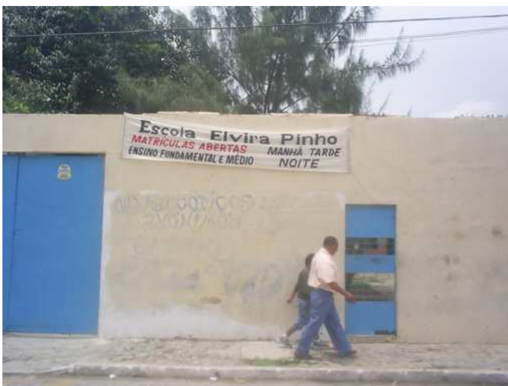
Muro, portões, faixa e pedestre na frente da Escola de Ensino Fundamental e Médio Elvira Pinho em Fevereiro de 2006.
