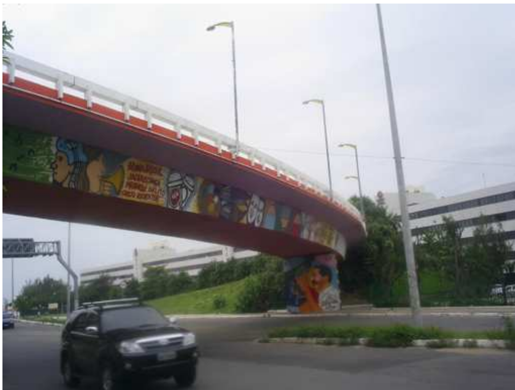
Grafite do Preto Rap no viaduto na Leste Oeste, enfrente ao Marina Park Hotel.
