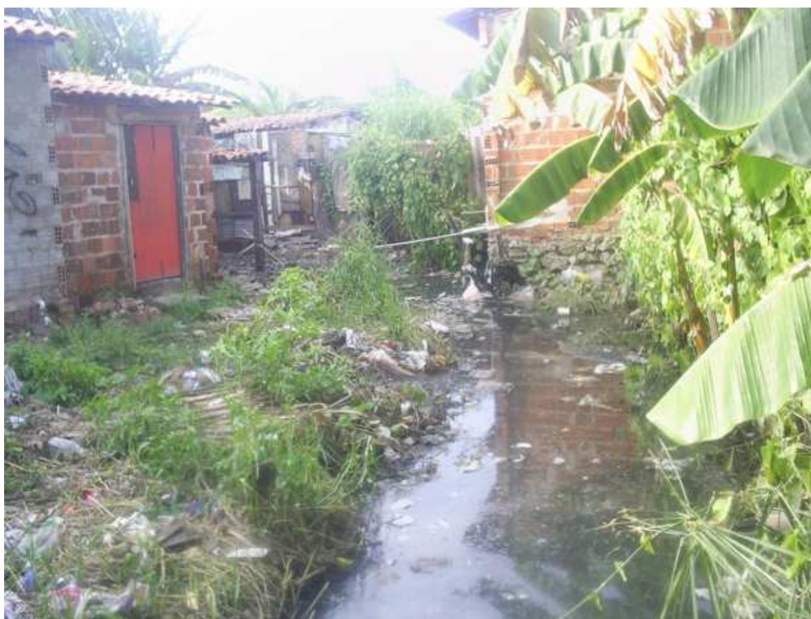
Corre a céu aberto, um “rio de lama” dentro da Comunidade Poço da Draga.
