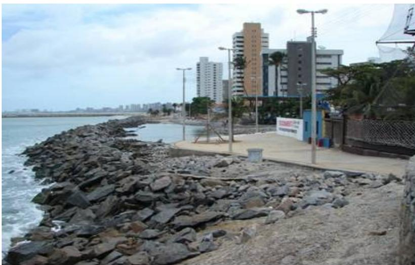
**Figura 73** - Trecho com obras de engenharia costeira para contenção da erosão ao longo da orla marítima na Praia de Iracema. Verificar a verticalização e o déficit de areia na faixa de praia e o calçadão da Praia de Iracema protegido por muralhas. **Fonte:** Fechine, outubro de 2006
