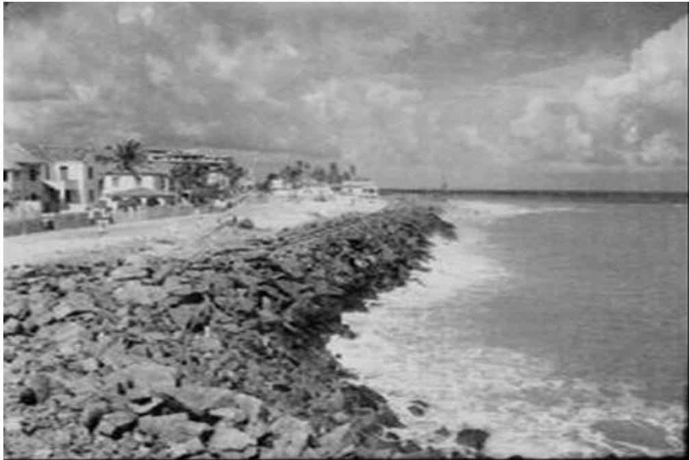
**Figura 45** - Praia de Iracema na década de 1960, evidenciando os enrocamentos rochosos construídos para inibir a erosão provocada pelo porto do Mucuripe. **Fonte:** Arquivo Nirez
