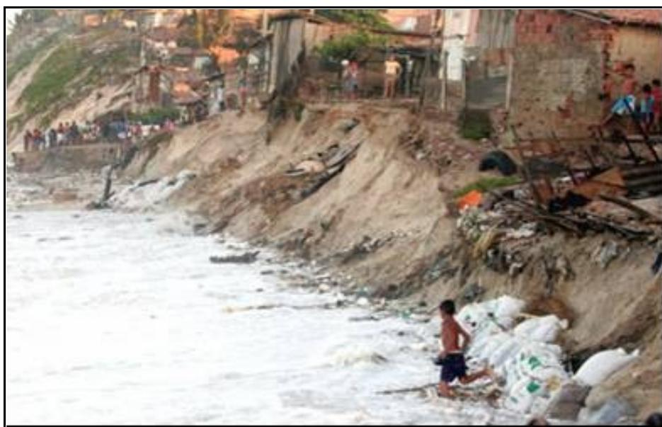
**Figura 79** - Intenso processo erosivo instalado no Bairro do Pirambu, atingindo áreas de aterros irregulares e faixa de praia. **Fonte:** Fechine, setembro de 2006
