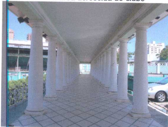
Passarela que liga o edifício ao ginásio
