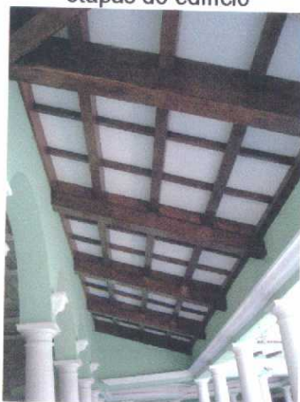
Estrutura da coberta
