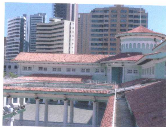
Vista geral da coberta
