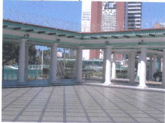
Pátio interno e passarelas
