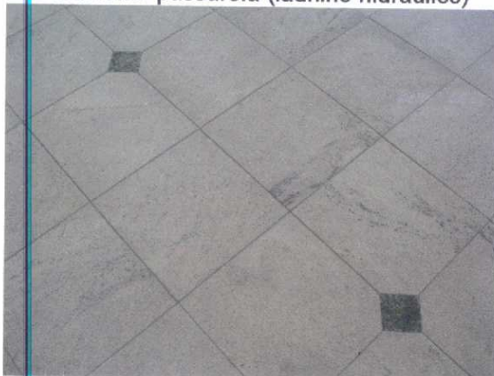
Pavimento salão nobre (mármore)
