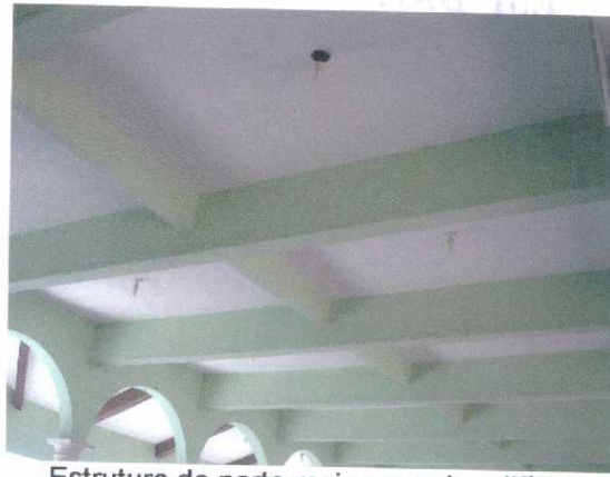
Estrutura da parte mais nova do edifício
