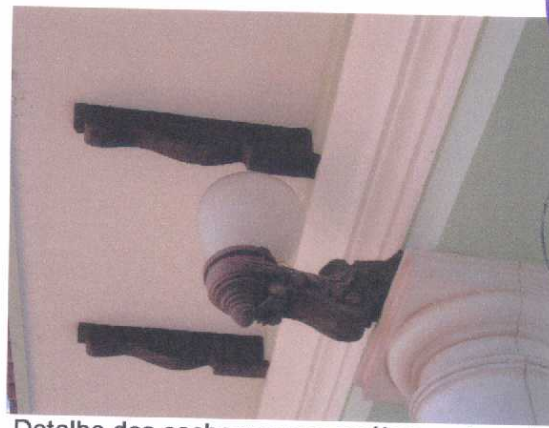
Detalhe dos cachorros que apóiam os beirais dos pórticos
