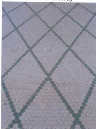
Pavimento passarela (ladrilho hidráulico)
