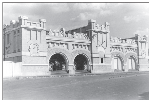
Estação Ferroviária do Crato, foto incluída no processo.
