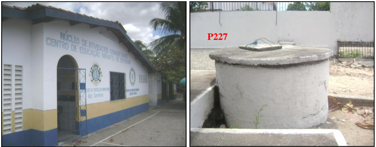
Figuras 6.2.8 e 6.2.9- Exemplo de poço manual (cacimba) com revestimento de pré-moldado (P227) localizado no bairro José Walter (Agosto/2010). Coord.: 9576269/548965
