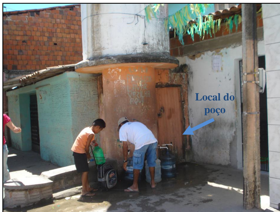
Figura 6.5.1 - Chafariz público no bairro da Serrinha, sendo a água captada através de poço tubular (P172), Fortaleza - CE (Agosto/2010). Coord.: 9581699/550193
