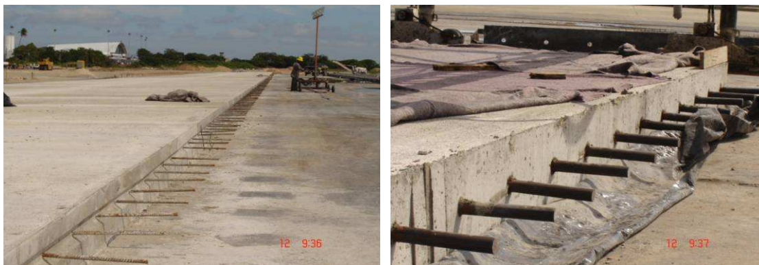
Figura 4.2 – Placas de concreto armado do Pátio 3.
