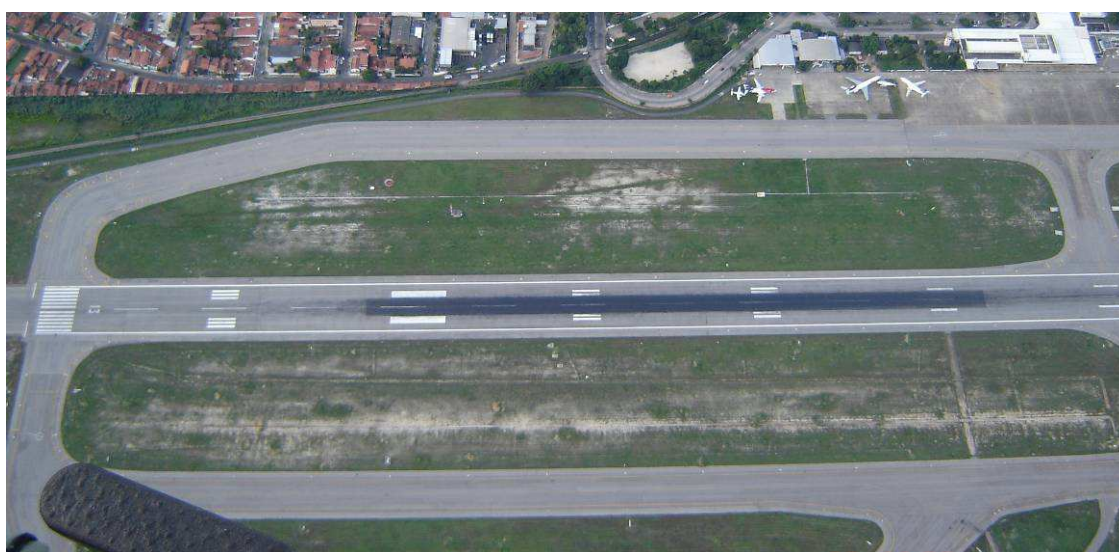
Figura 3.20 – Vista aérea da faixa de pista não-conforme. INFRAERO (2008d).
