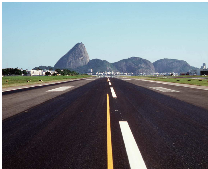
Figura 2.12 – Camada Porosa de Atrito aplicada no Aeroporto Santos Dumont, Rio de Janeiro. BR DISTRIBUIDORA (2005).
