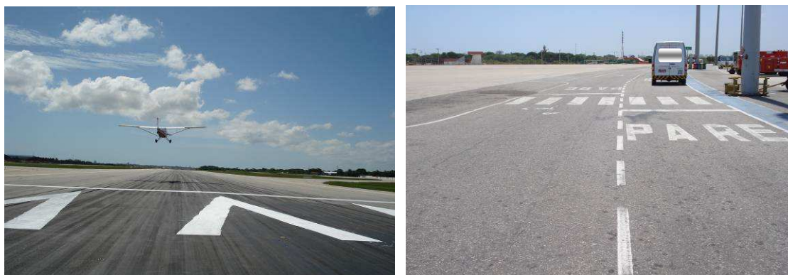
Figura 4.5 – Pavimento flexível em áreas do Aeroporto Internacional de Fortaleza.
