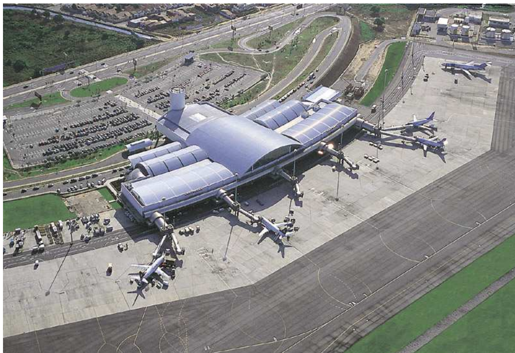
Figura 3.17 – Vista aérea do terminal de passageiros e pátio. INFRAERO (2008d).
