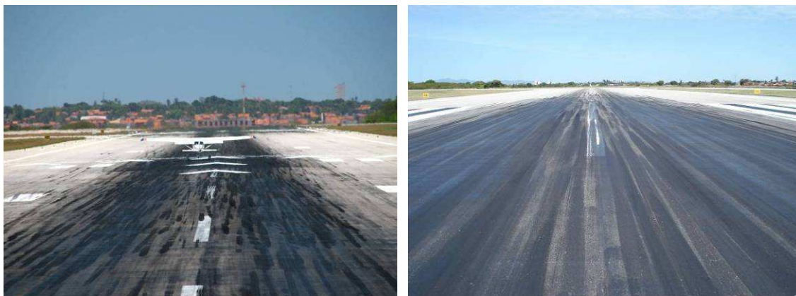
Figura 5.26 – Borracha impregnada na superfície da pista de pousos e de decolagens.
