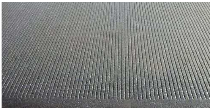
Figura 2.13 – Grooving em pavimento aeroportuário.
