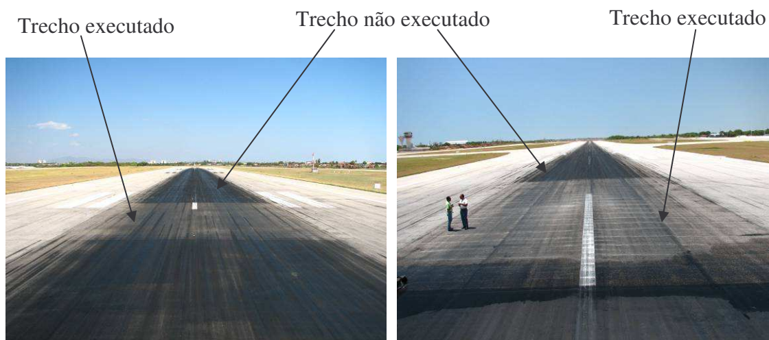
Figura 5.28 – Áreas da pista de pousos e de decolagens, com e sem a execução dos serviços de remoção da borracha acumulada.
