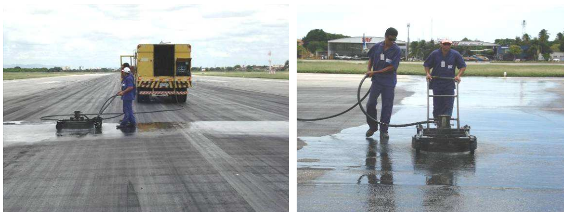
Figura 5.27 – Serviços de remoção de borracha com jato de água de alta pressão.
