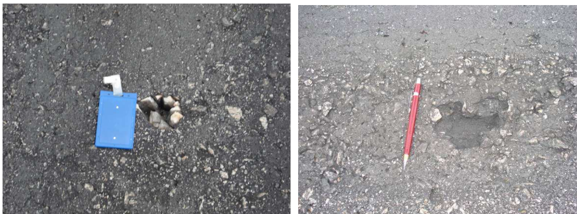
Figura 5.23 – Desagregações.
