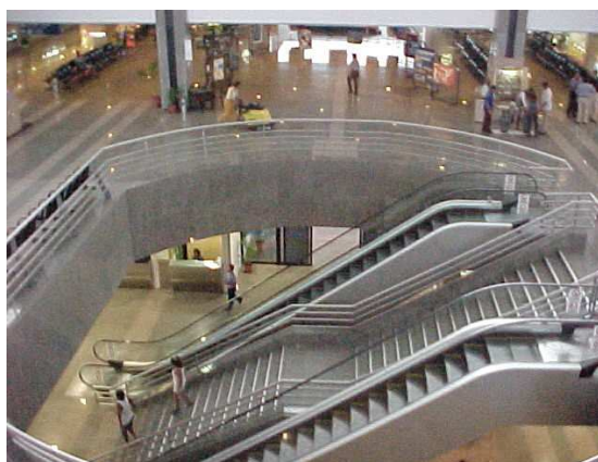
Figura 3.16 – Escadas rolantes do saguão central. INFRAERO (2008d).
