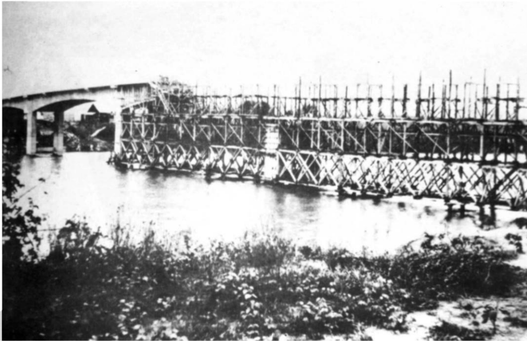
PONTE JEQUIÉ — Outro aspecto da enchente quando as águas quasi atingiram a parte inferior da treliça do escoramento
