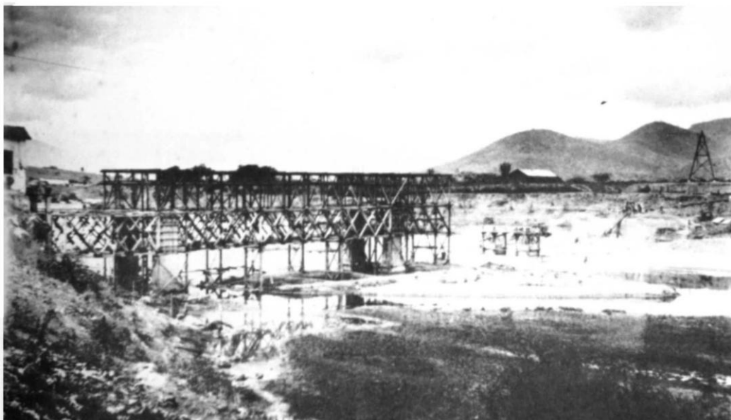
PONTE JEQUIÉ — Aspecto da construção quando se iniciava a terceira ordem do escoramento no lance da margem esquerda
