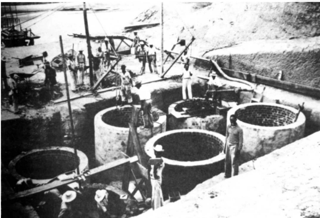
PONTE JEQUIÉ — Penetração dos tubulões para as fundações do encontro da margem direita
