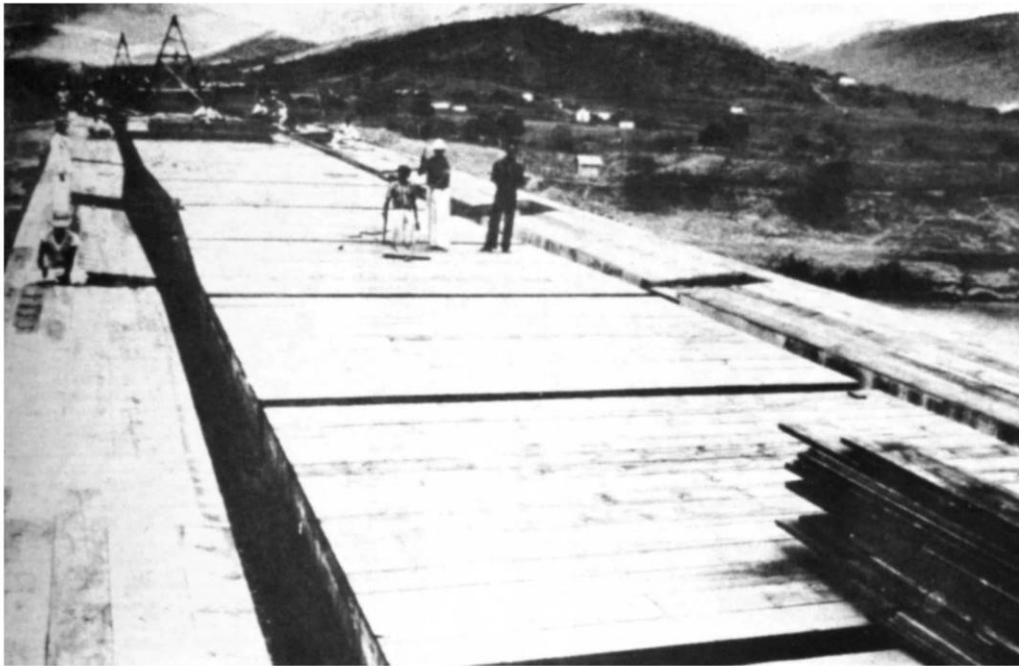
PONTE JEQUIÉ — Formas das vigas, travessas e estrado em conclusão
