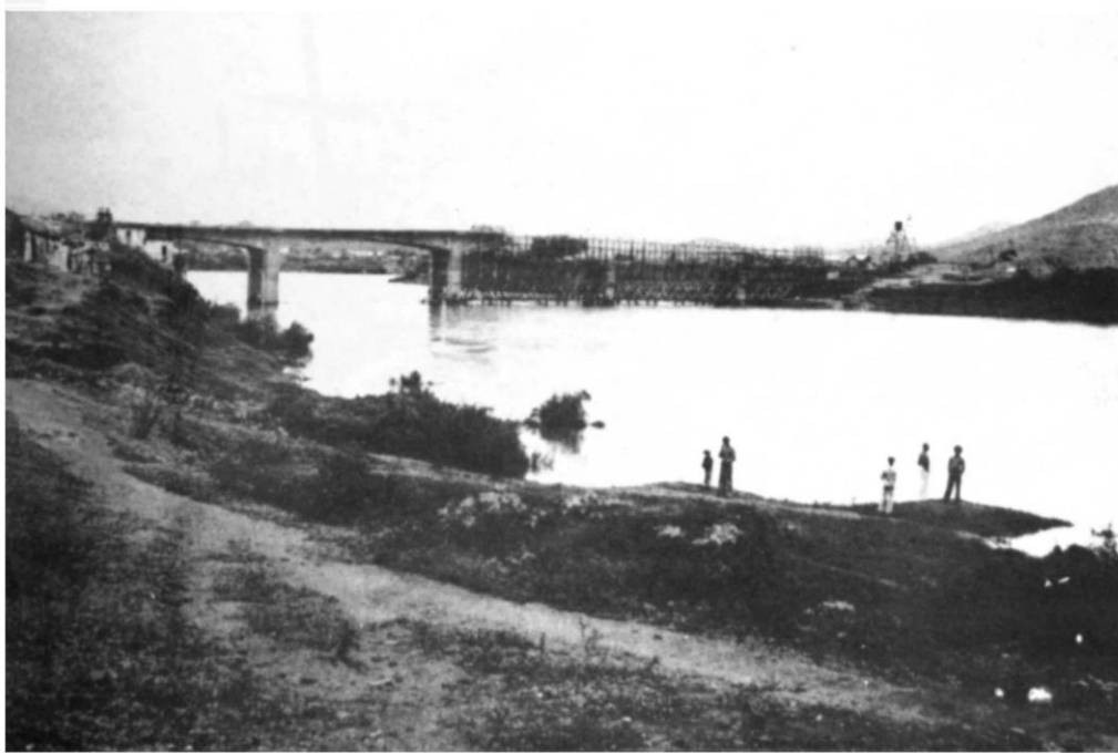
PONTE JEQUIÉ — Aspecto da obra por ocasião de uma enchente do rio
