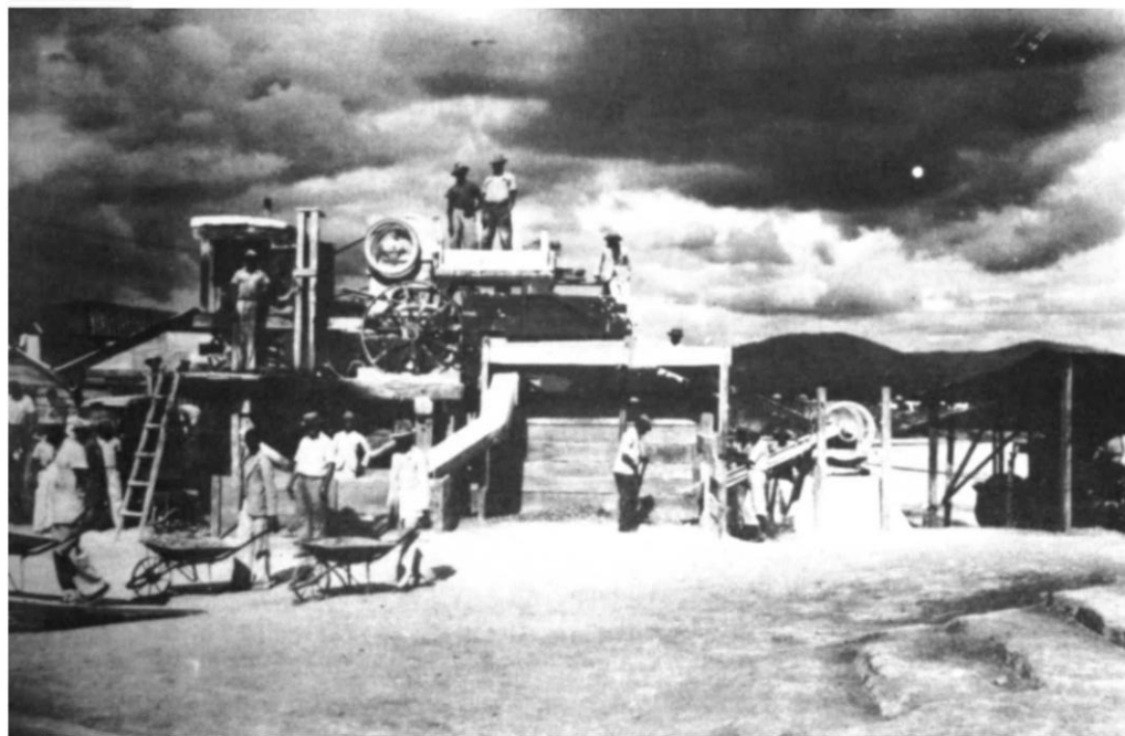
PONTE JEQUIÉ — Instalação de britadores
