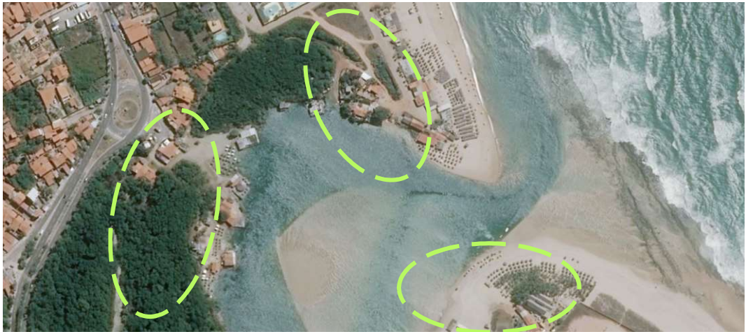
Figura 25: Ponto Nodal localizado na foz do Rio Cocó
