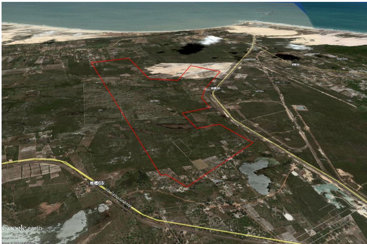
FIGURA 2 - Panorâmica do terreno da Companhia Siderúrgica do Pecém (CSP).
