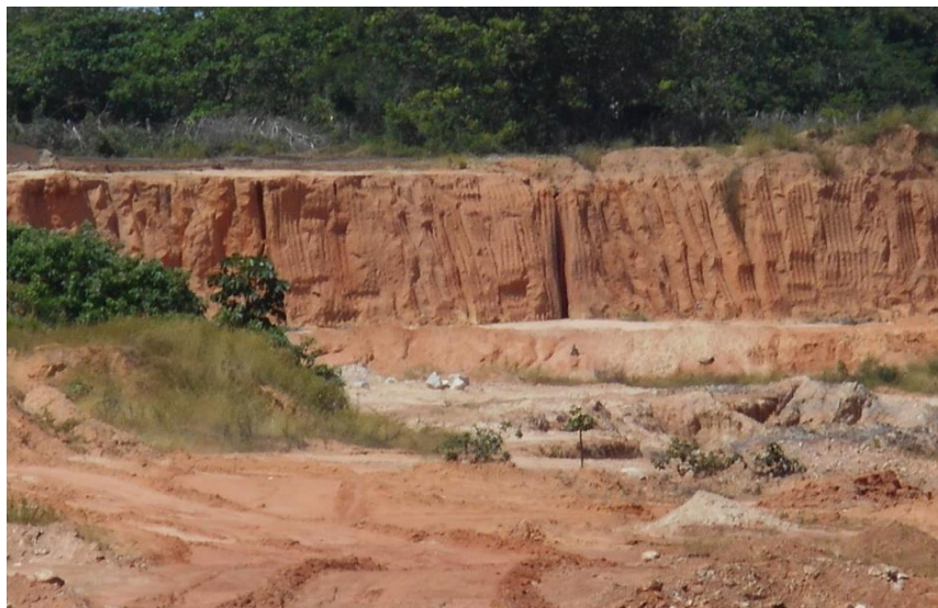
FIGURA 25 - Exposição dos sedimentos areno-argilosos Barreiras na Rodovia CE 155.
