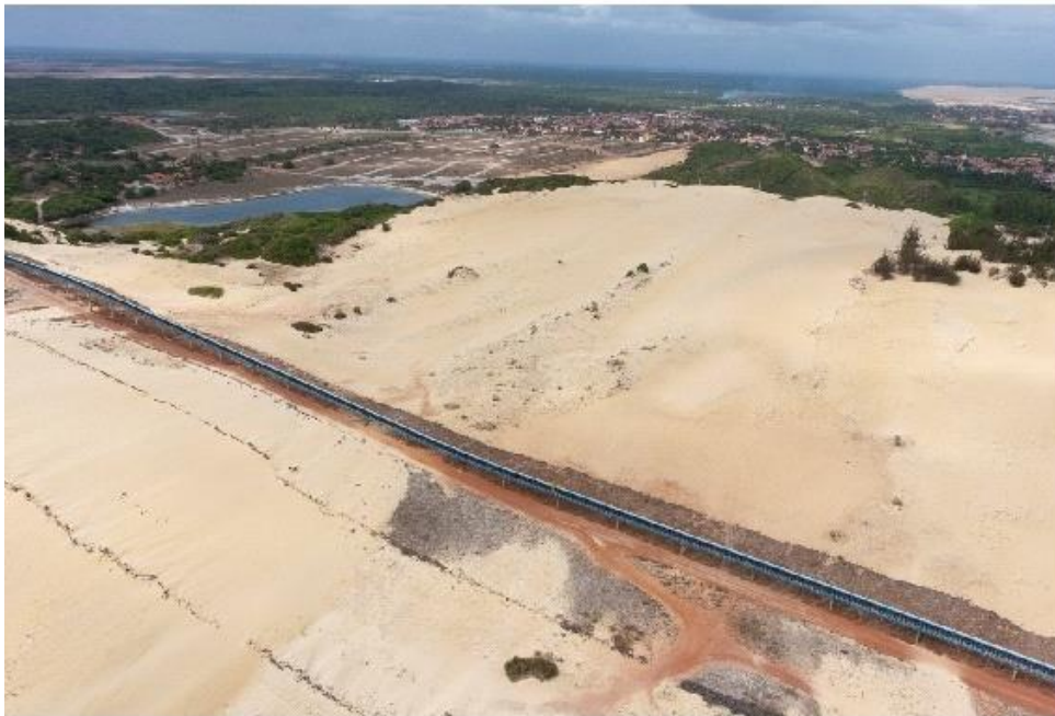
FIGURA 4 - Correia transportadora de carvão mineral interceptando cordões da Formação Dunas.
