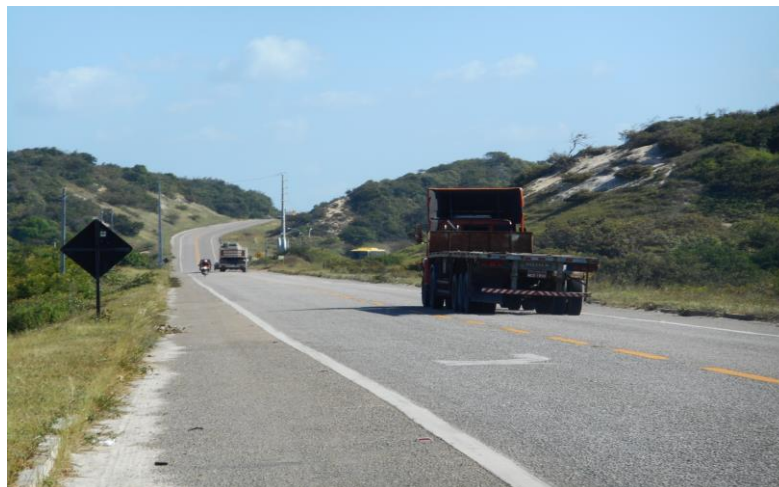
FIGURA 27 - Rodovia CE-155 de acesso ao Porto do Pecém, interceptando cordão de dunas.
