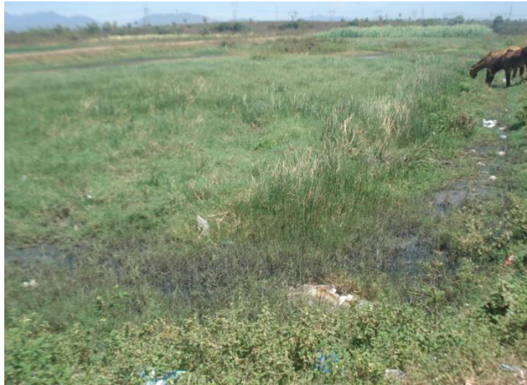
Imagem 2 – Lagoa de estabilização localizada no Conjunto Palmeiras com elevado estágio de assoreamento
