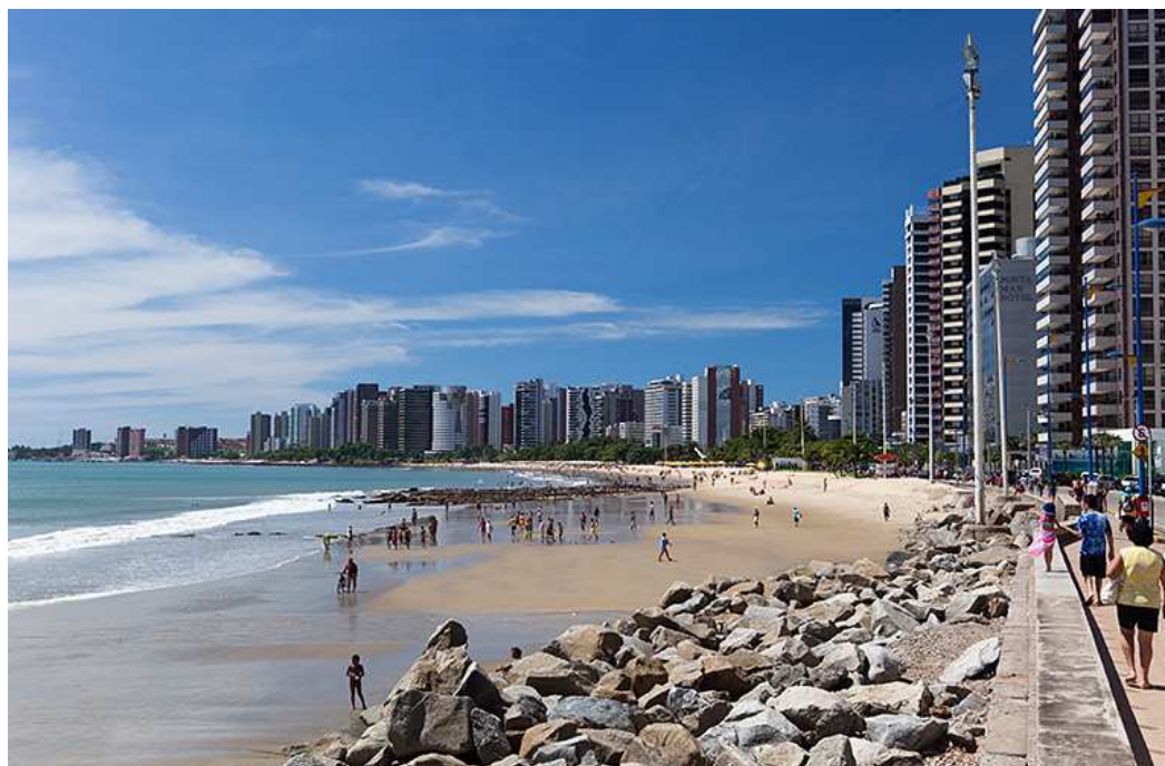
Foto 43: Proteção direta por enrocamento ao longo de toda linha de maré onde ocorre erosão na Praia do Meireles.
