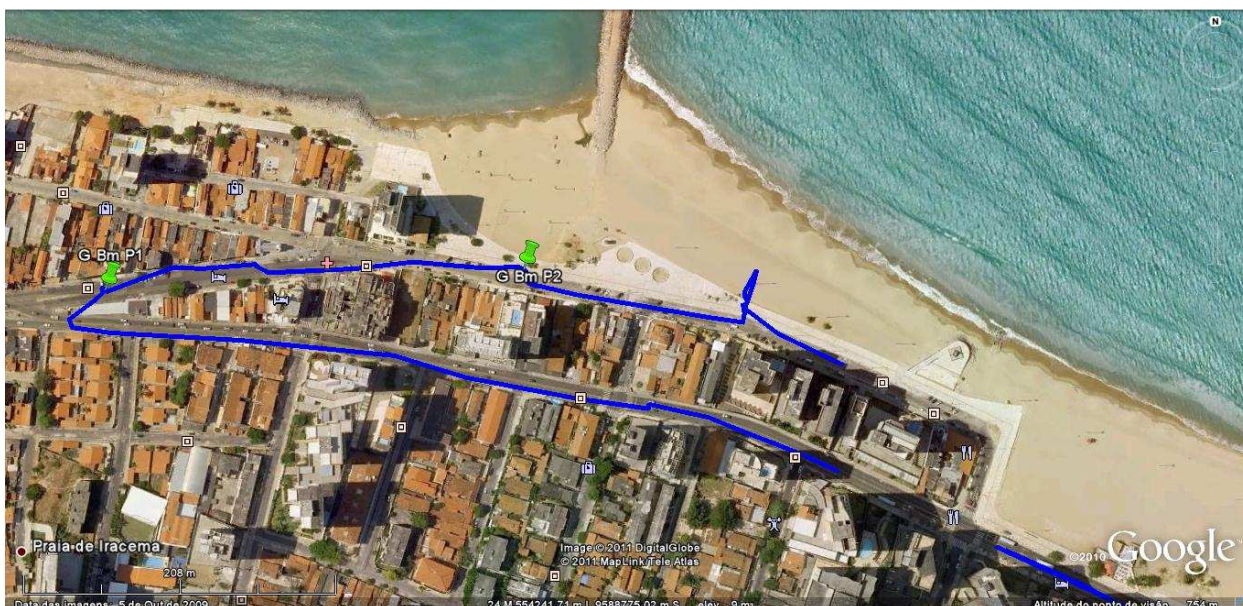
Foto 17: Trecho próximo da ponte metálica, na praia de Iracema, onde encontram-se os pontos 1 e 2, na AID.
