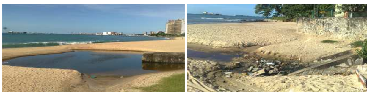
Foto 37: Saída da drenagem na rede pluvial e saída da drenagem na rede pluvial
