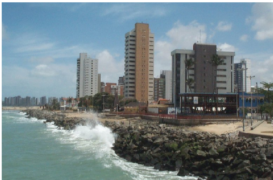
Foto 04: Vista da Praia de Iracema, próximo a Ponte dos Ingleses, onde se observam contenções para proteção da infra-estrutura urbana e de imóveis.
