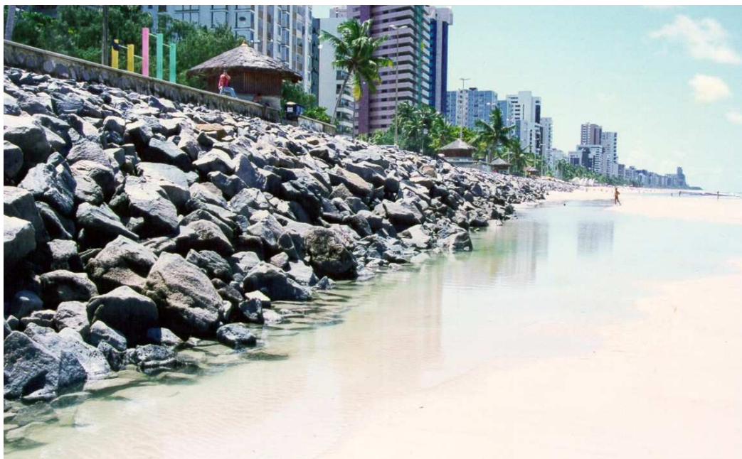
Foto 08: Exemplo de muro de proteção aderente dissipativo e permeável na Praia de Boa Viagem, orla marítima do município de Recife-PE.
