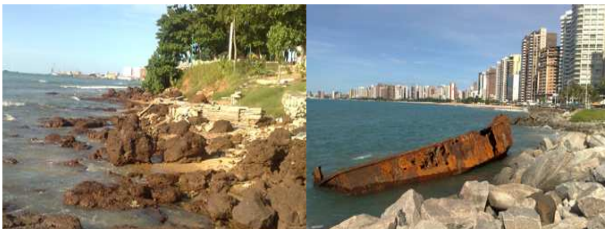
Foto 36: Destruição da costa com processos erosivos.
