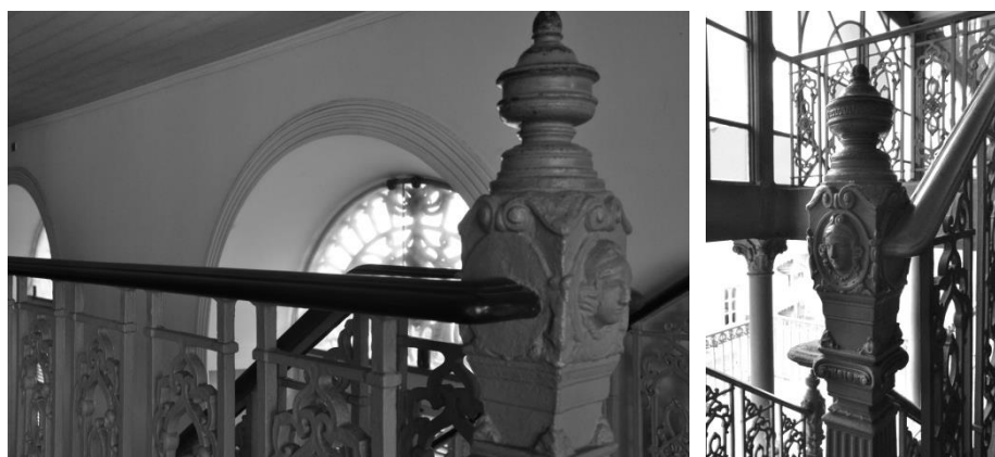
Figura 126 – Detalhe do arremate do corrimão da escada
