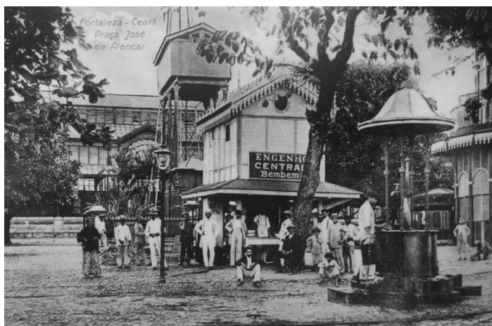
Figura 88 – Caixa d’água - Garapeira do Bembém
