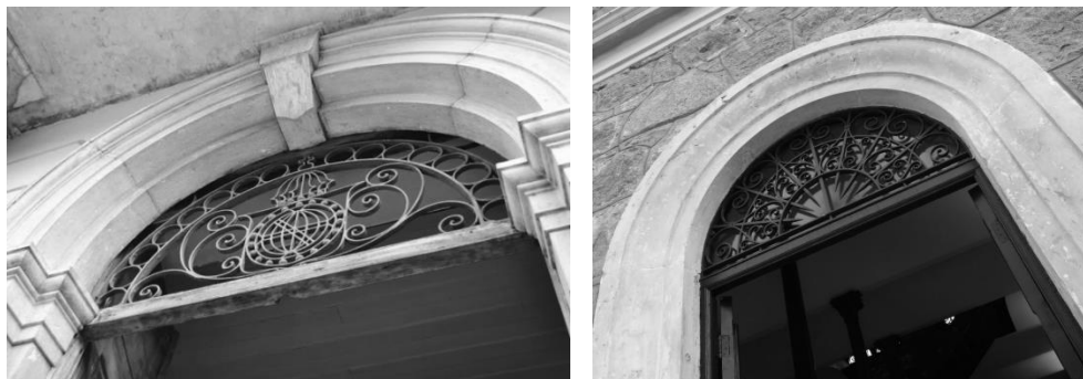
Figura 50 – Bandeira de ferro e portal de pedra aparelhada - Assembléia e Alfândega
