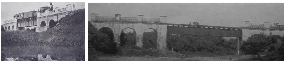
Figura 55 – Ponte do Rio Acarape
