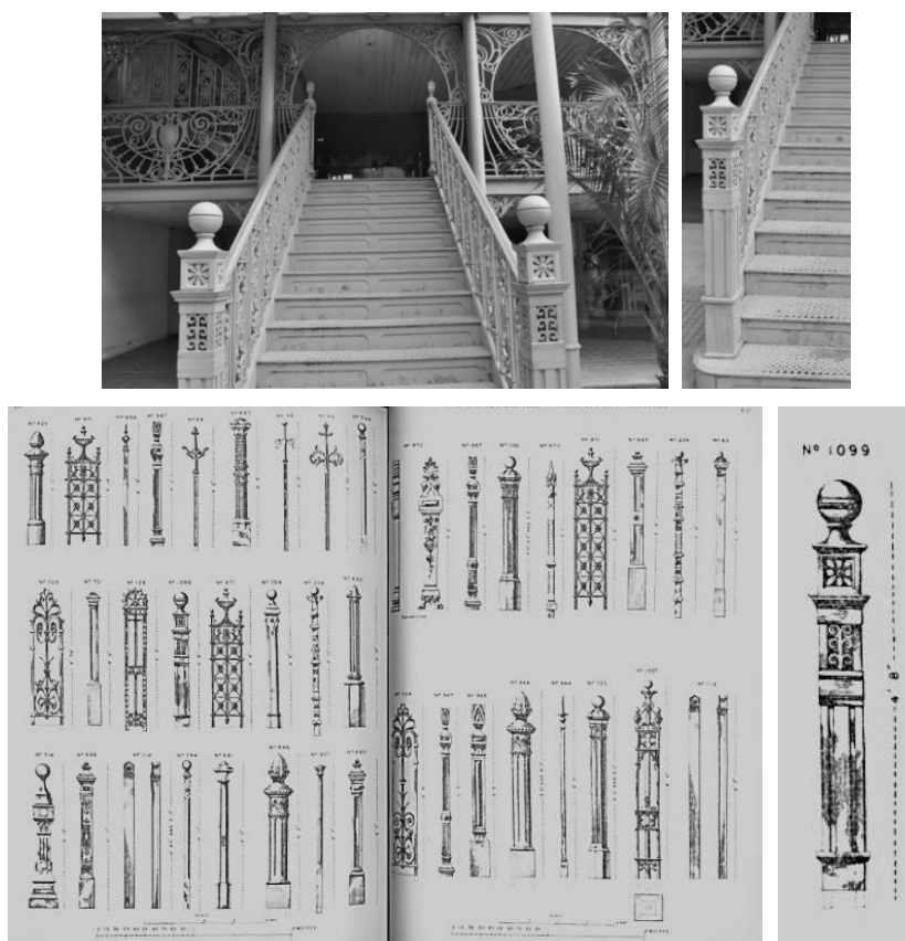
Figura 120 – Escada de acesso ao 1º pavto. e modelos de coluna de corrimão
