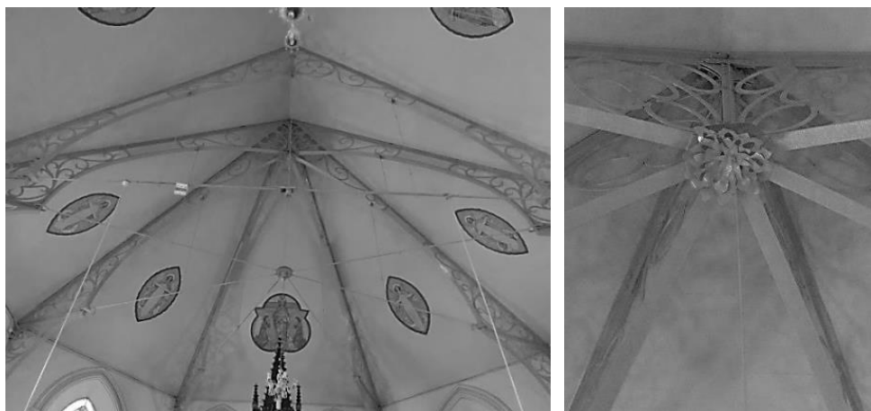
Figura 99 – Encontro da Estrutura Metálica - Detalhe
