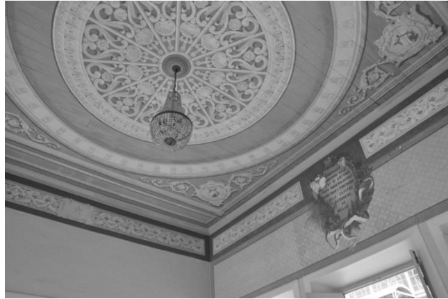
Figura 129 – Pintura decorativa no forro do vestíbulo do foyer
