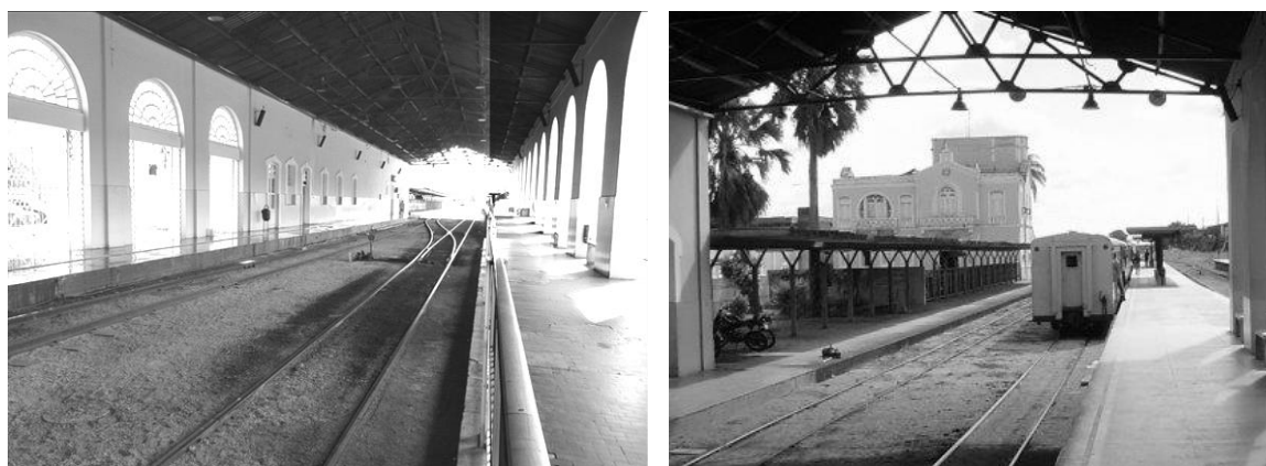
Figura 65 – Vista interna da plataforma da Estação Central - coberta em estrutura metálica
