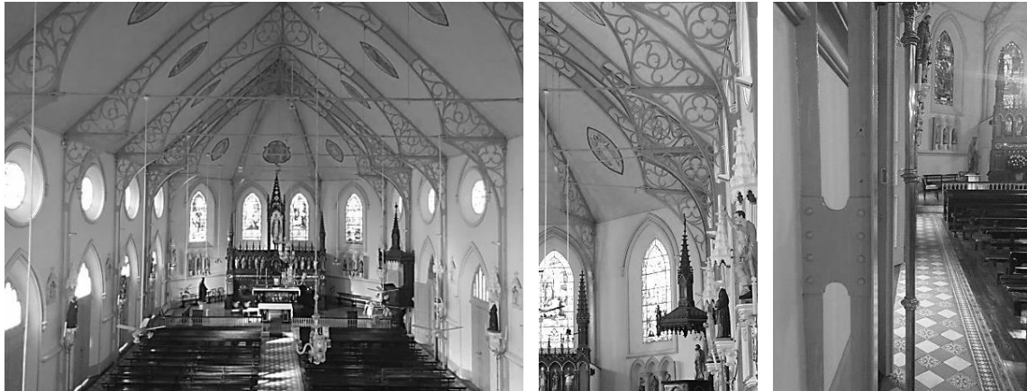
Figura 98 – Estrutura Metálica - Pórticos - Nave Central - Cortes
