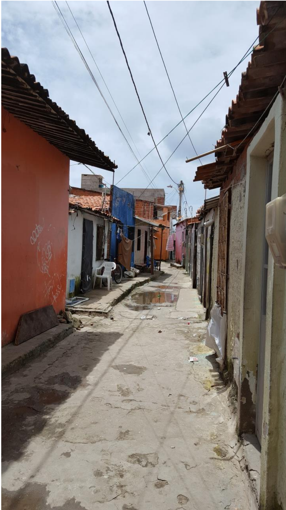
Figura 16: Rua com pavimentação do tipo "cimentado". Fonte: Equipe Técnica UNIFOR, 2019
