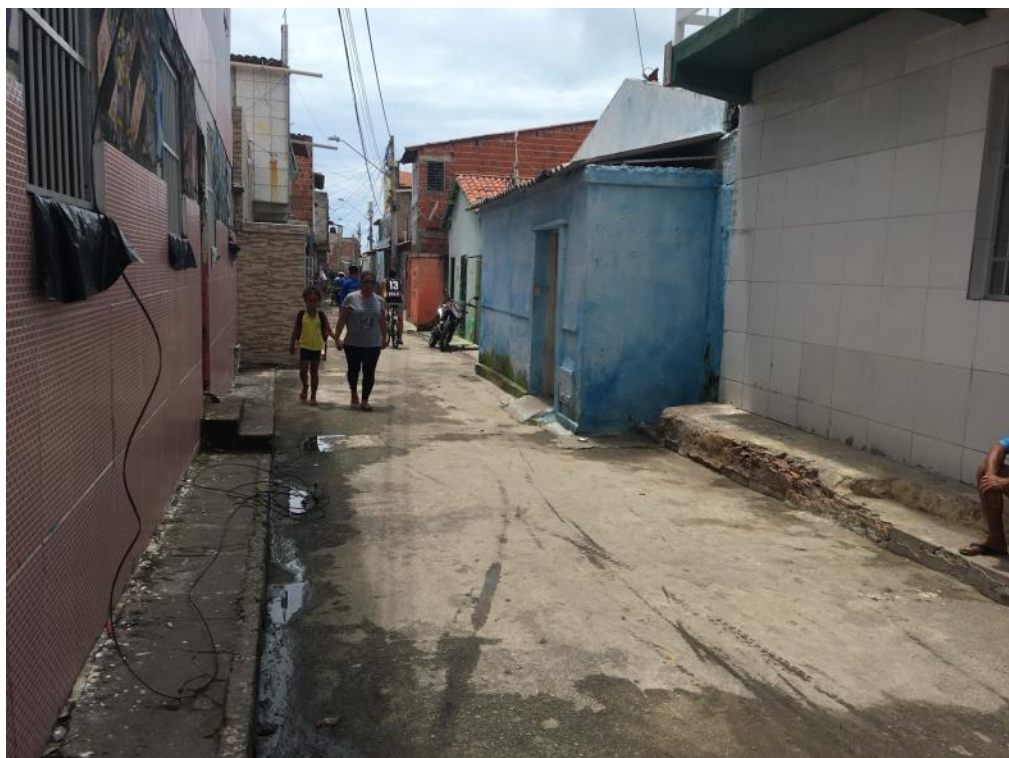
Figura 18: Rua com edificações avançando sobre as calçadas. Fonte: Equipe Técnica UNIFOR, 2019.
