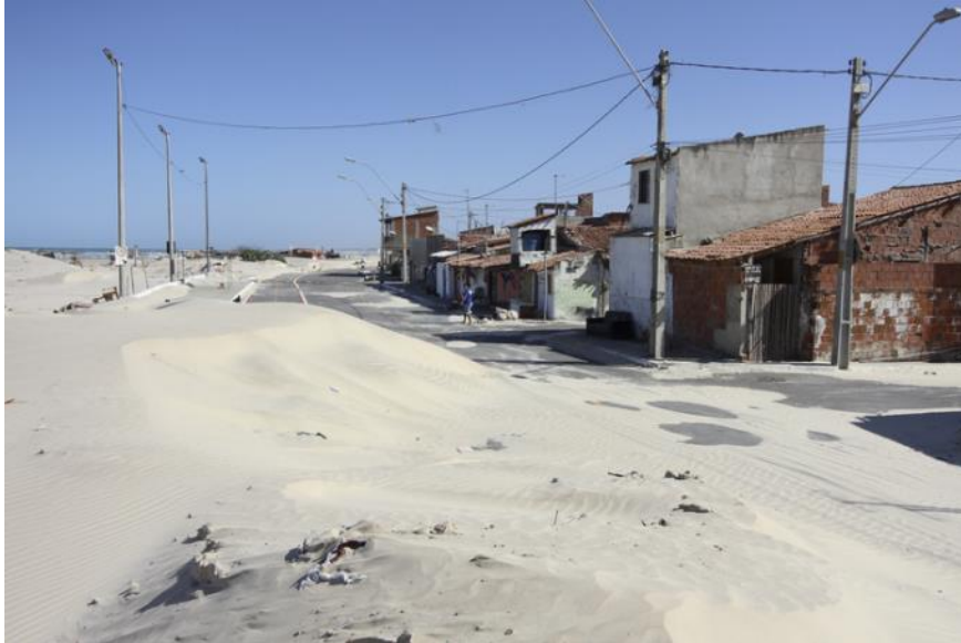
Figura 04: Avanço de sedimentos por sobre a via e encaminhando-se em direção às casas, mesmo após intervenção urbanística, em 2017.
