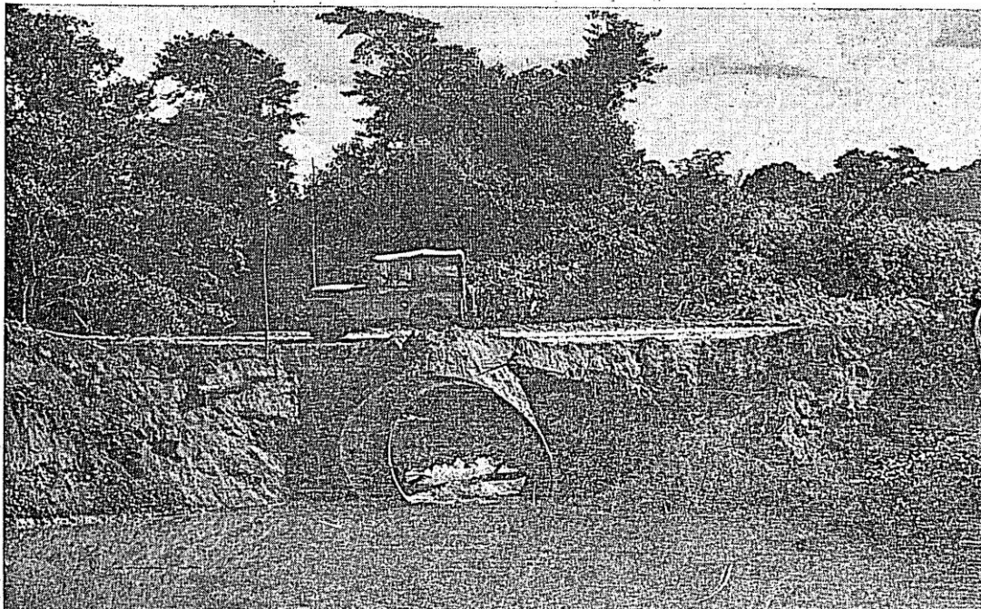
Rodovia Nordeste-Brasília iniciada com flagelados da seca de 1958. Bueiro metálico de 3,5 m de diâmetro no Rio Cana Brava no trecho Barreiras-Formosa. Maior obra rodoviária do DNOCS.
