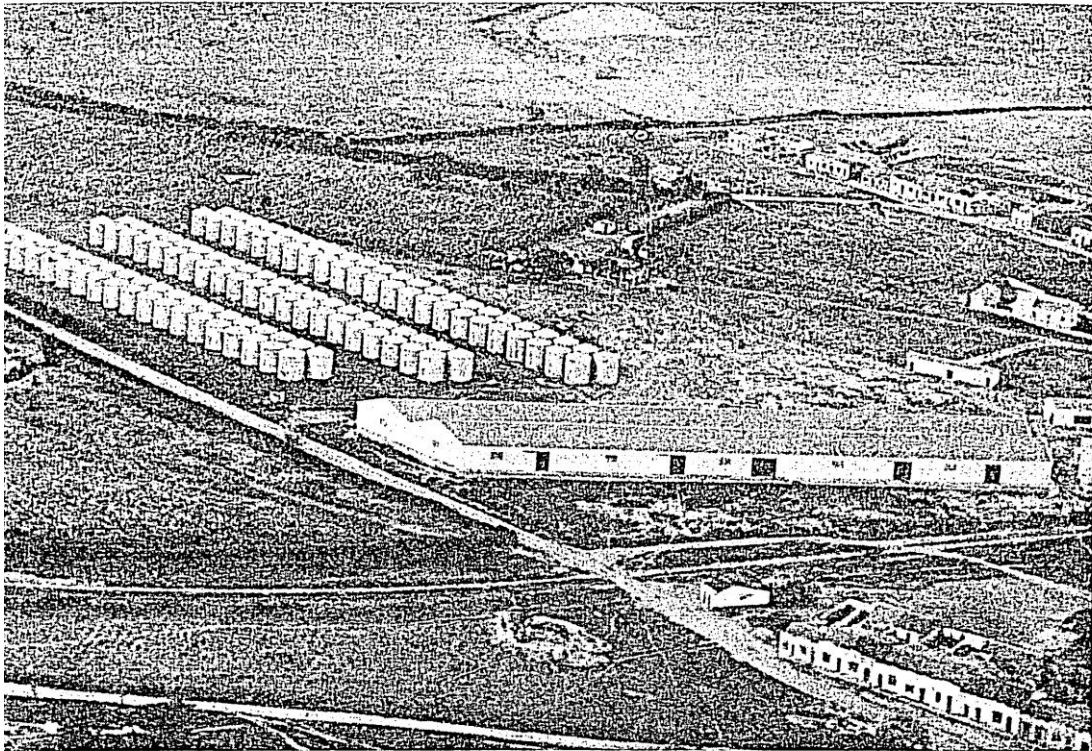
Armazens e silos de Caruaru, no Estado de Pernambuco. Capacidade total de 25.160 t, sendo 8.600 t em armazens e 16.560 t em silos.
