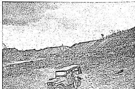
Atêrro rodoviário em construção durante a sêca de 1958.
