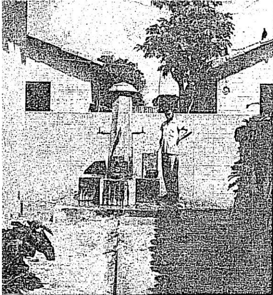
Bicas distribuidoras de um poço profundo em zona residencial no Ceará.
