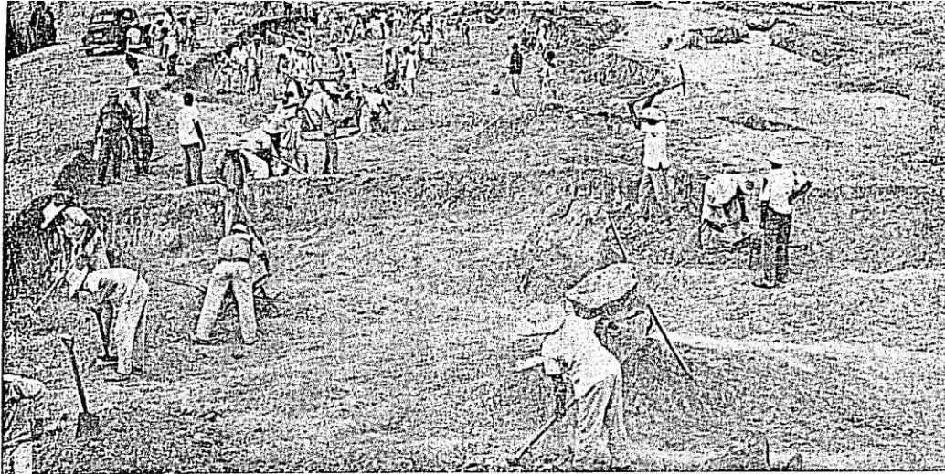
Açude Custódia (ex-Junco II), iniciado com flagelados da seca de 1958, no Município de Custódia, Sistema do Moxotó, Estado de Pernambuco. Escavação das fundações em agosto de 1958.
