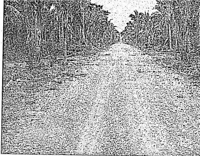
Rodovia Teresina-Palmeiras. Trecho em tráfego. Estado do Piauí.
