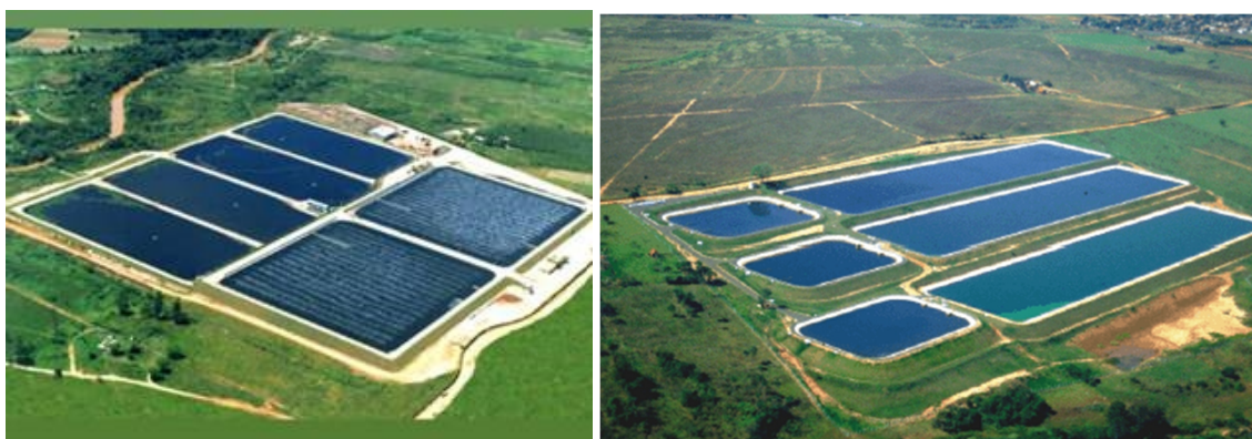
FIGURA 10 – LAGOAS DE ESTABILIZAÇÃO
