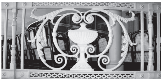
Figura 3b. Variante do Gradil nº. 1093 , aplicada no pavimento térreo do Teatro Jose de Alencar. (Foto: F. Veloso).
