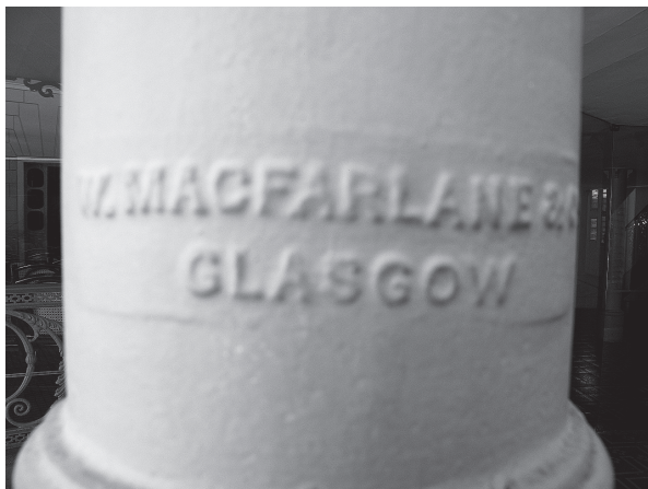
Figura 13. Marca de Walter Macfarlane & Co. nas colunas metálicas do Teatro José de Alencar. (Foto: F. Veloso).
