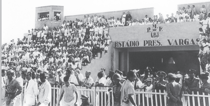
Foto 10 - Detalhe do estádio Presidente Vargas. Arquibancada de cimento armado, lugar especial, vendo-se ao alto à esquerda, cabine da imprensa. (Arquivo Nirez).
