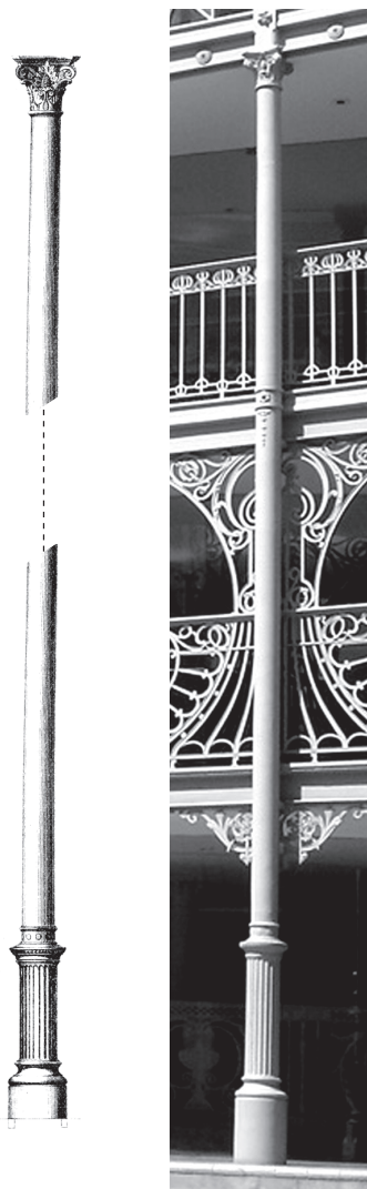
Figura 8b. Coluna nº. 156 , aplicada no Teatro José de Alencar. Observar parte de conduto de gás de iluminação, ainda mantido após o emprego de iluminação elétrica. (Foto: F. Veloso).
