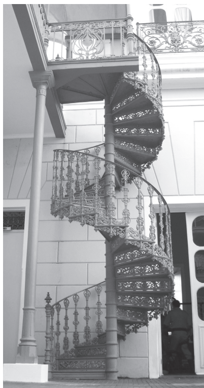
Figura 11b. Escada helicoidal nº. 639 , aplicada no Teatro José de Alencar (balaústres do corrimão escolhidos circunstancialmente). (Foto: F. Veloso).
