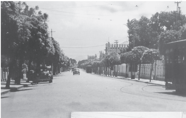
Foto 1 - Início da avenida Visconde de Cauipe, próximo as “caixas d’água”.
