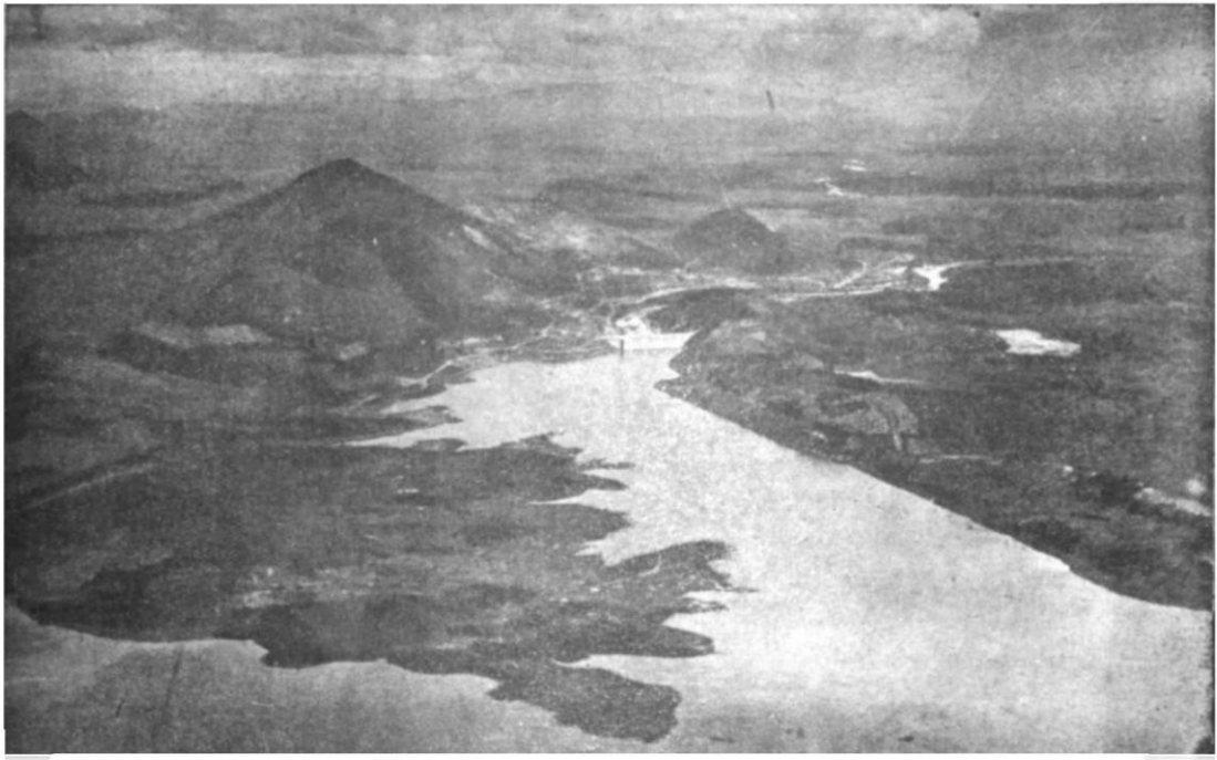
Vista aerea do açude "General Sampaio", descortinando parte da bacia hidraulica, a barragem, a torre, o passadiço e, ao fundo, o acampamento.
