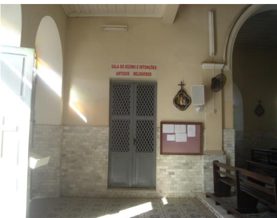
Vista da entrada principal
