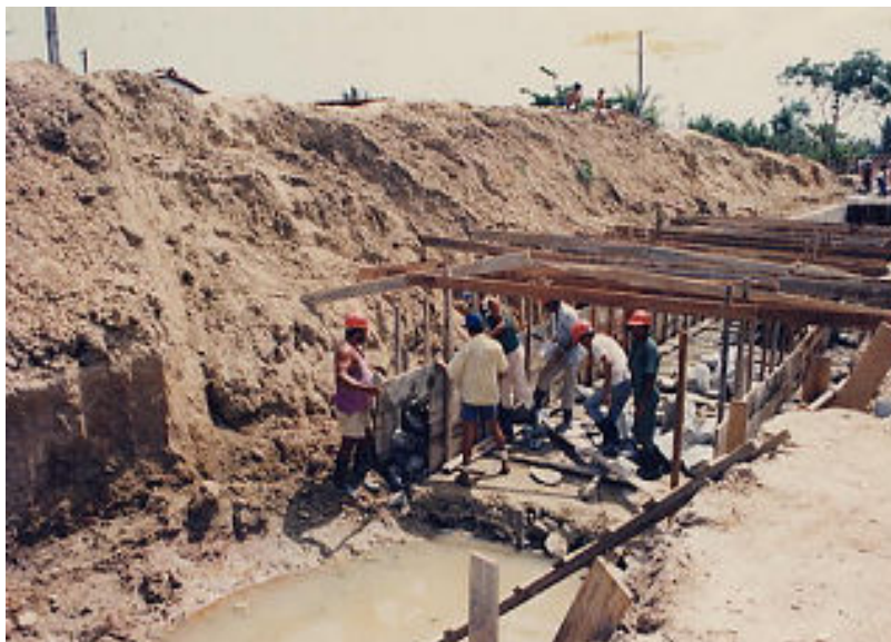
Figura 10 – Foto da construção do Canal de Drenagem
