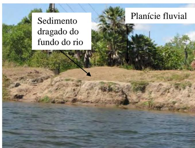
Foto 42 - Sedimento retirado do leito do rio Cocó e lançado sobre a planície fluvial da margem direita, quando a retificação de seu curso.
