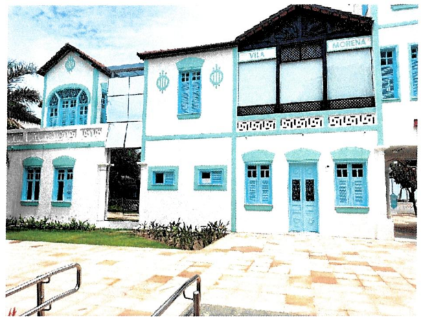
Figura 01. Edifício Estoril. Fonte: CPHC, 2022.
