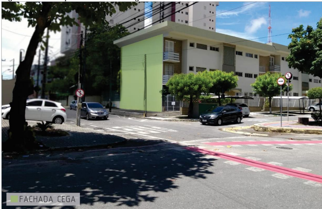
Figura 39: Edificação com fachada cega.
