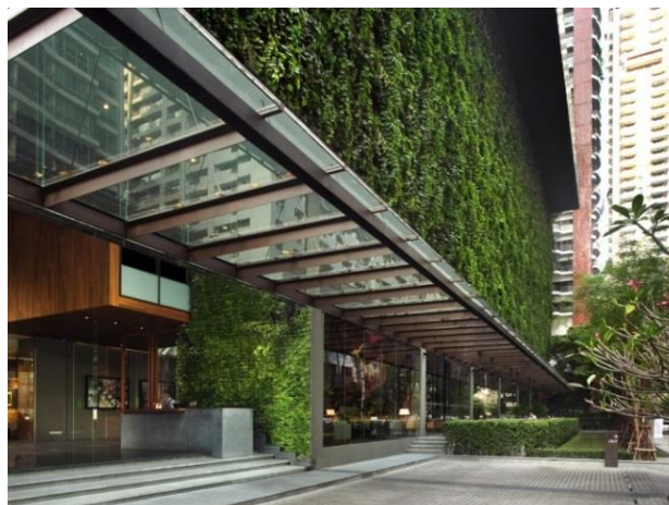
Figura 18: Pavimento térreo de edifício Comercial em Bangcoc- Tailândia
