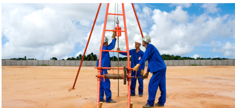
Foto 01: execução de sondagem geotécnica
