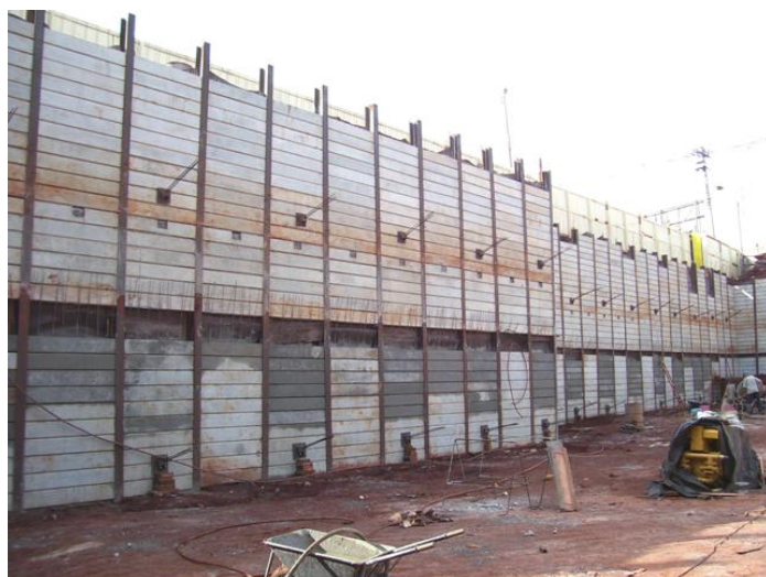
Foto 09: vista lateral da cortina executada
