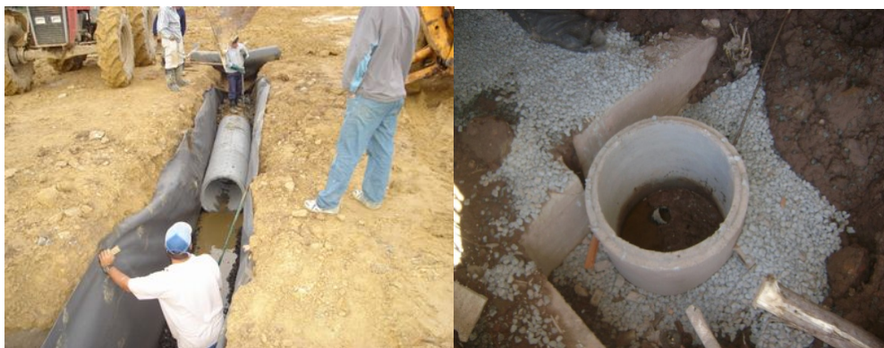
Foto 10 e 11: drenagem do subsolo c/ bombas submersas interligada a um sistema de anilhas
