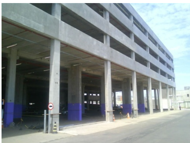
Foto 13: estrutura em concreto edifício garagem Fonte: http://www.preconcretos.com.br
