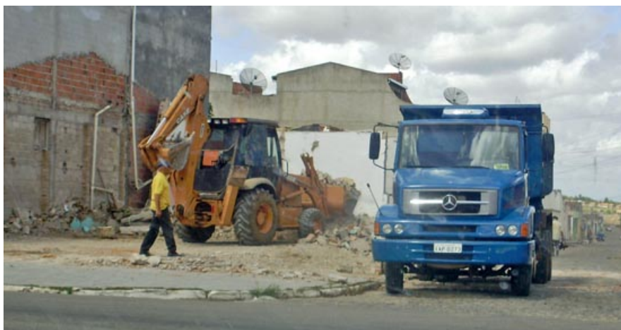
Foto 03: execução de sondagem geotécnica
