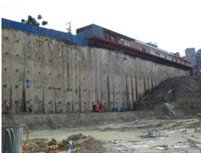
Foto 12: Execução de contenção com parede diafragma atirantada
