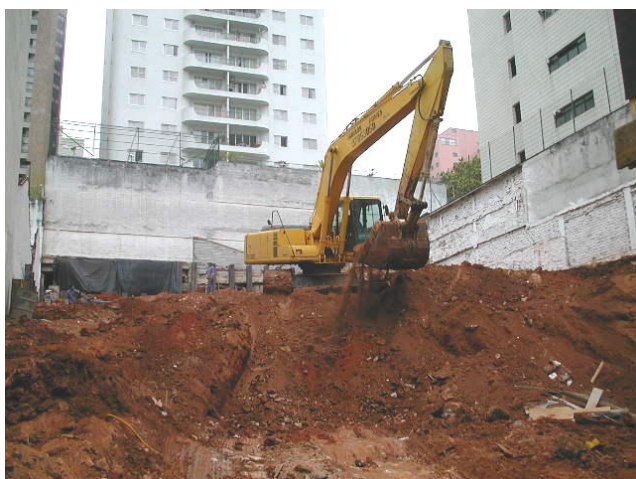
Foto 04: execução de sondagem geotécnica
