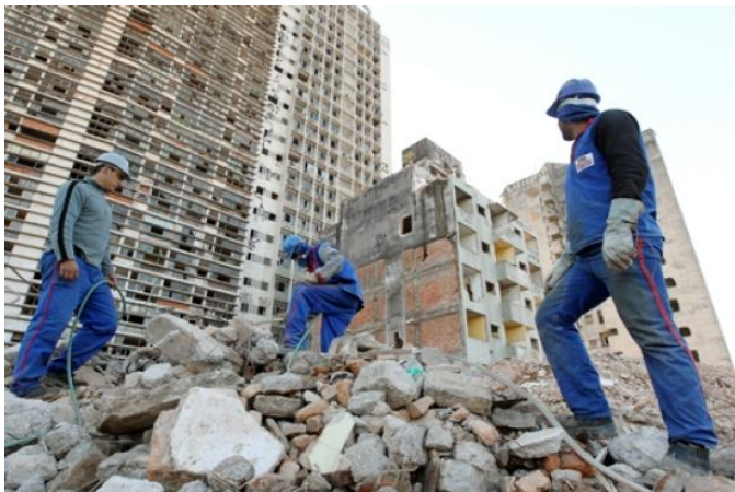
Foto 02: execução de demolição Fonte: http://www.ciclovivo.com.br/noticia .
