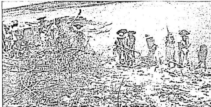
Trabalhadores das turmas de emergência de 1958, empregados no desmatamento e limpeza da bacia hidráulica do Açude Público Riacho da Sangue, no Município de Solonópolis, no Ceará. Aproveita-se o abaixamento do nível d'água no reservatório durante as crises de seca para tais trabalhos.
