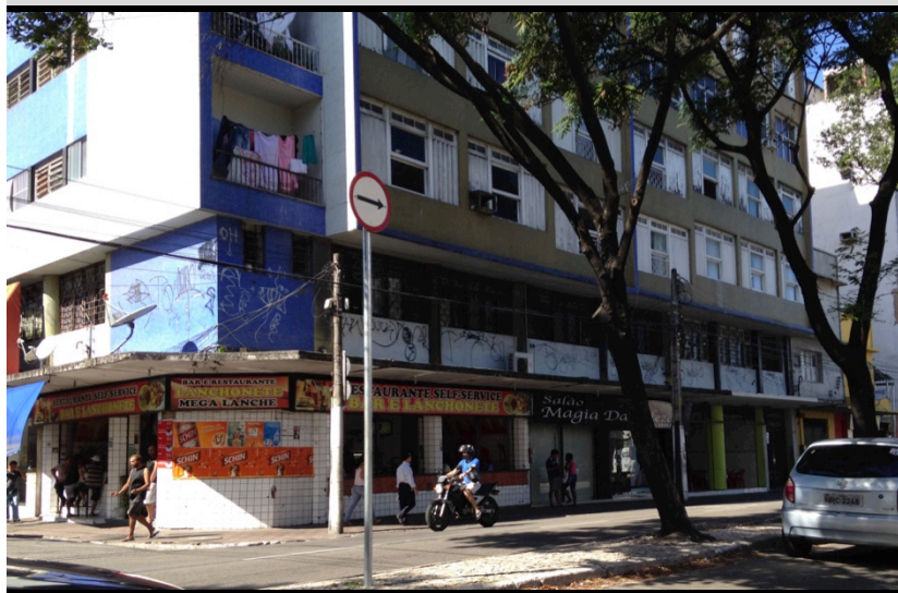
Imagem 4.5 – Edifício Fortaleza, situado à Avenida Duque de Caxias, Centro da cidade de Fortaleza.
