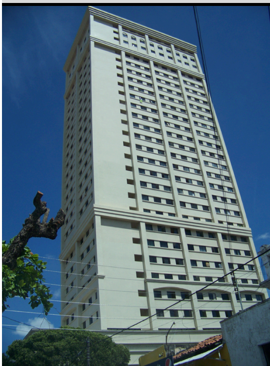
Imagem 4.17 – Edifício Sky Tower, à Rua 25 de Março. Edifício residencial de multipavimentos.
