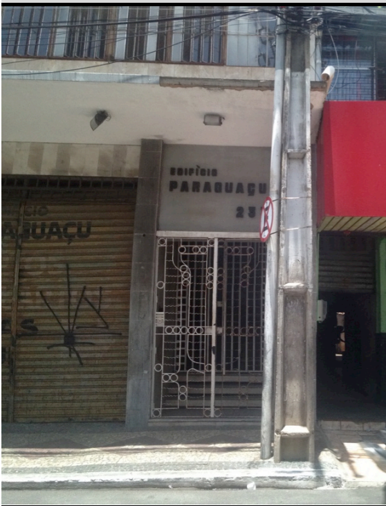
Imagem 4.14 – Edifício Paraguaçu, localizado no cruzamento da Rua Pedro I e da Rua Solon Pinheiro.
