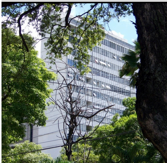
Imagem 4.12 – Edifício Paraguaçu, localizado no cruzamento da Rua Pedro I e da Rua Solon Pinheiro.
