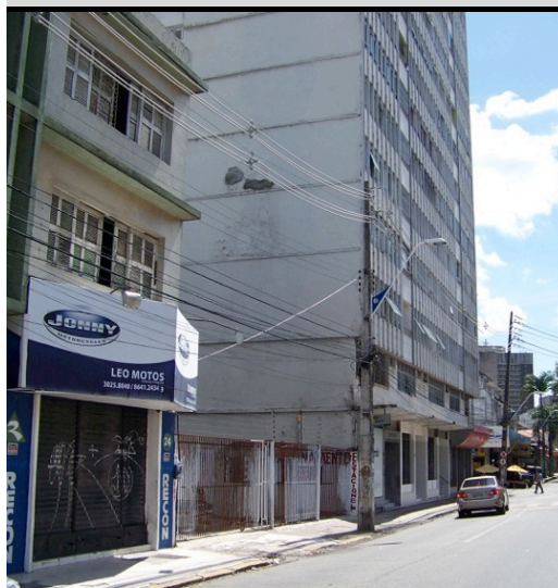
Imagem 4.13 – Edifício Paraguaçu, localizado no cruzamento da Rua Pedro I e da Rua Solon Pinheiro.
