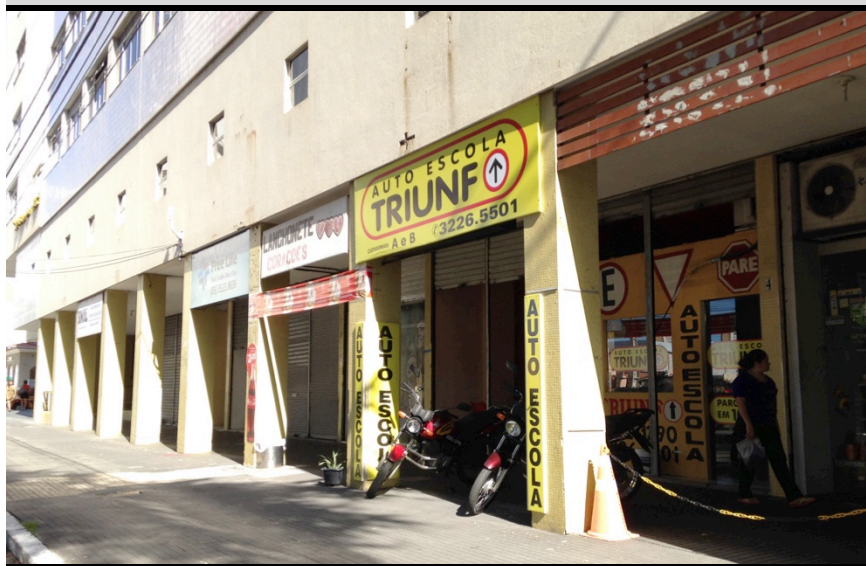
Imagem 4.11 – Área comercial do Edifício Palácio Coronado.
