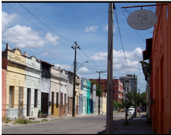
Imagem 5.9 – Residências Unifamiliares localizadas na Rua Pero Coelho.
