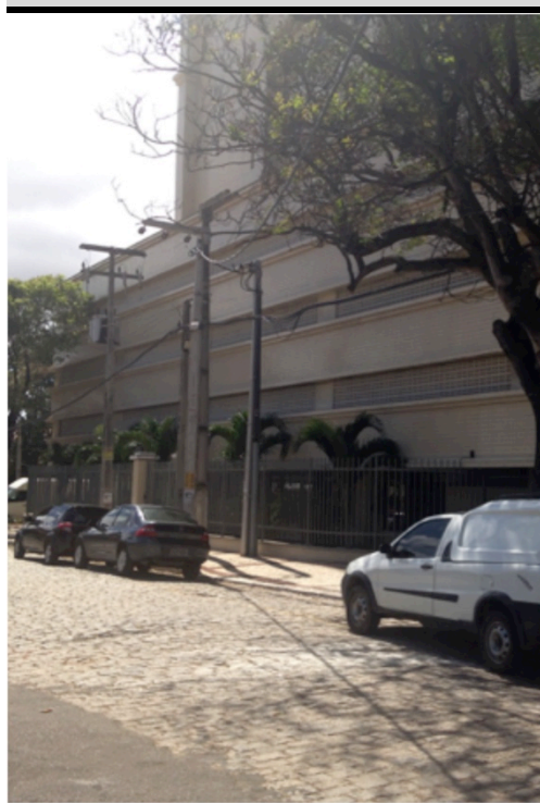
Imagem 4.18 – Edifício Sky Tower, à Rua Pereira Filgueiras. Edifício residencial de multipavimentos.
