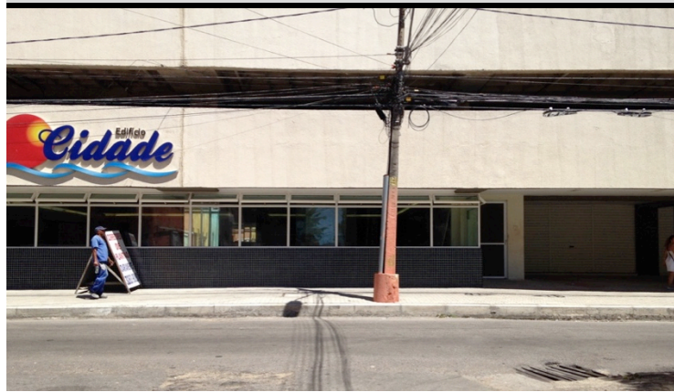
Imagem 4.21 – Área de Acesso de Pedestres do Edifício Cidade.
