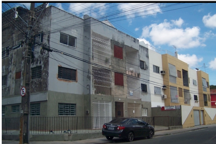
Imagem 5.21 – Edifícios multifamiliares de pequeno porte, Rua Liberato Barroso
