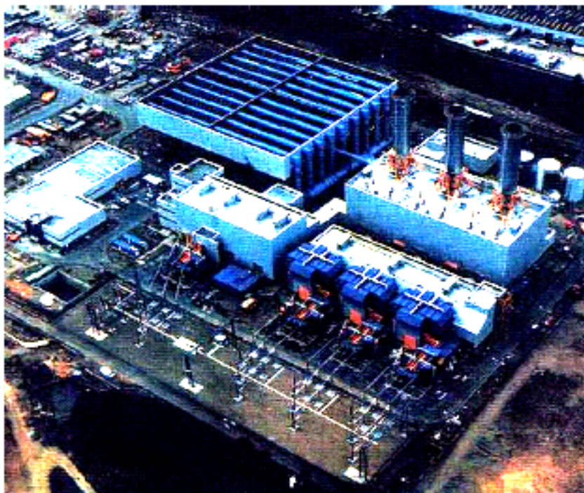
FOTO Nº 20 – USINA RYE HOUSE COM CAPACIDADE PARA 719 MW, INSTALADA NO REINO UNIDO
