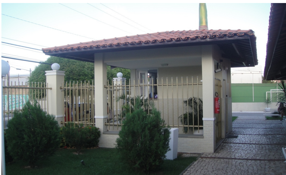
Figura 65. Vista da portaria (guarita) com compartimento com dois portões, onde o visitante espera ter sua entrada liberada.
