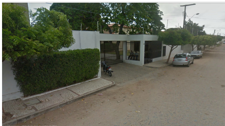
Figura 52. Aspectos do fechamento e passeios do condomínio Idezith Câmara.
