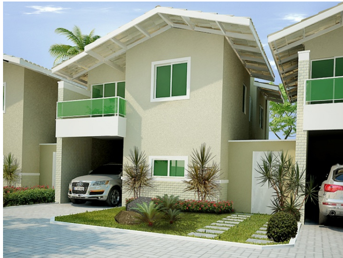
Figura 83. Fachadas das casas do condomínio Évora Boulevard.
