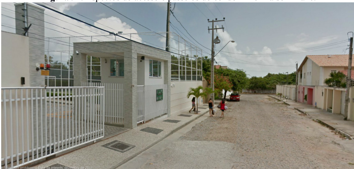
Figura 91. Aspectos do acesso e passeios do condomínio Maison Blanc.
