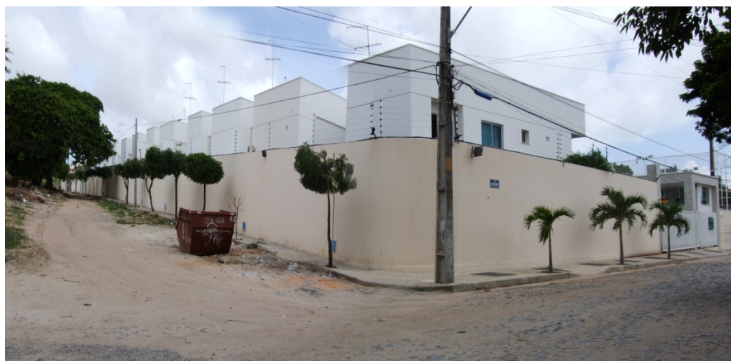
Figura 88. Entorno do condomínio Maison Blanc. Confluência da rua Cel. Olegário Memória com travessa Olegário Memória.
