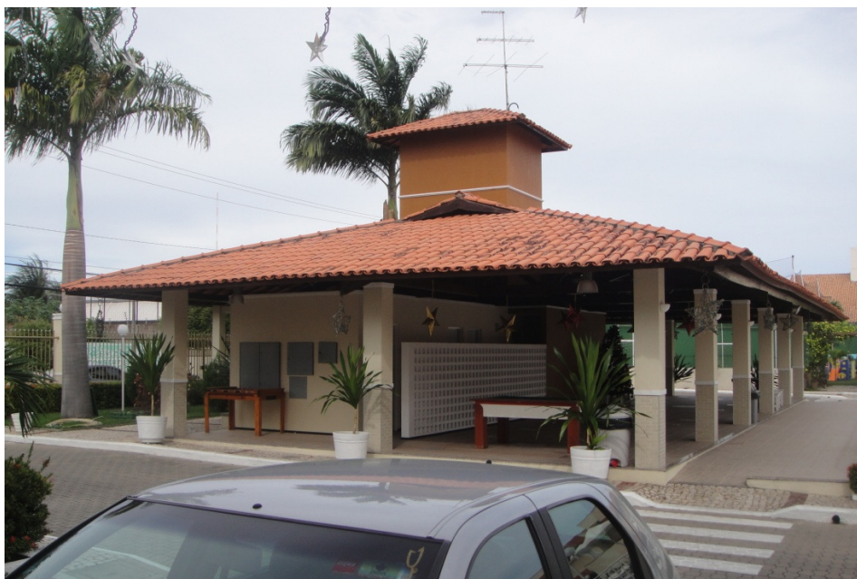
Figura 64. Vista do salão de festas e varanda de apoio à piscina.
