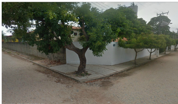
Figura 51. Aspectos do fechamento e passeios do condomínio Idezith Câmara.
