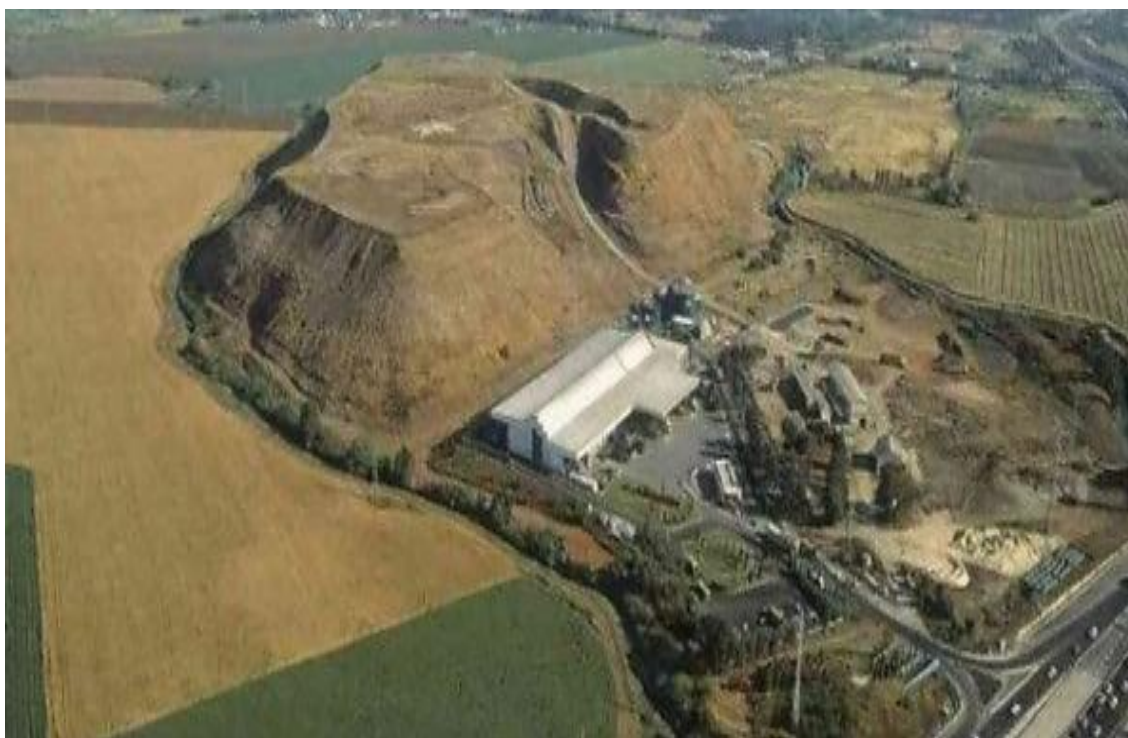
FIGURA Nº 27.5 – MONT HIRIYA ANTES DA RECONFIGURAÇÃO DO ATERRO
