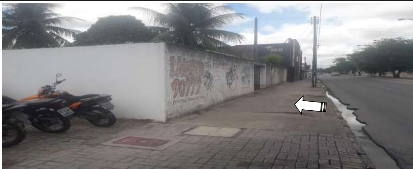
Foto 1 – Vista da via principal que dá acesso ao empreendimento, Av. Francisco Sá, sentido Sul. Coordenadas UTM: 555706E / 9583077N
