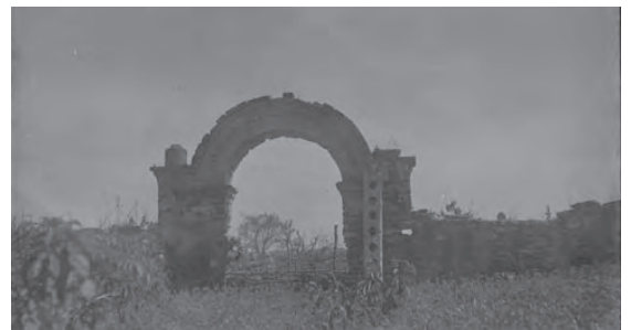
Figura 114: Curral com arcos que cita João José Rescala no relatório. Fonte: IPHAN/CE, 1941
