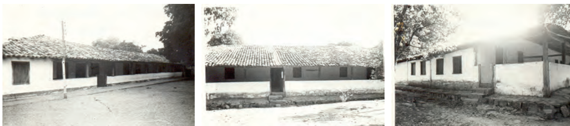
Figura 73: Fotos da casa da Fazenda São Domingos. Fonte: Arquivo FUNDAC-PI.
