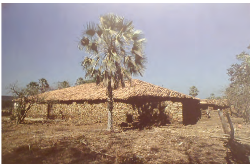
Figura 92: Alvenaria de pedra - Fazenda Santa Rita. Fonte: SILVA FILHO, 2007 c: 105.
