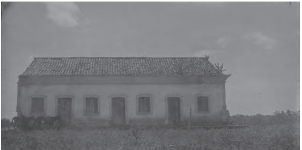
Figura 115: Casa da Fazenda Belmonte. Fonte: IPHAN/CE, 1941
