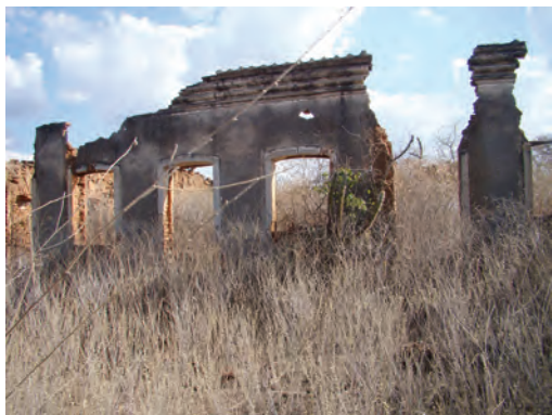
Figura 116: Ruína da casa da Fazenda Belmonte.
