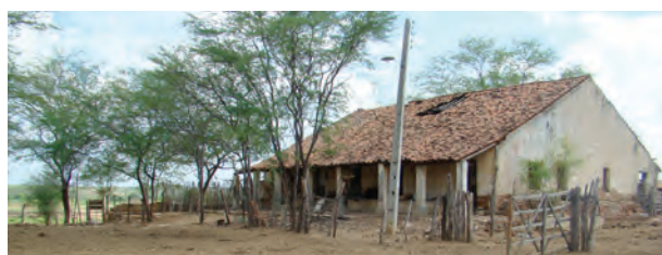
Figura 189: Casa da Fazenda Ipueira.
