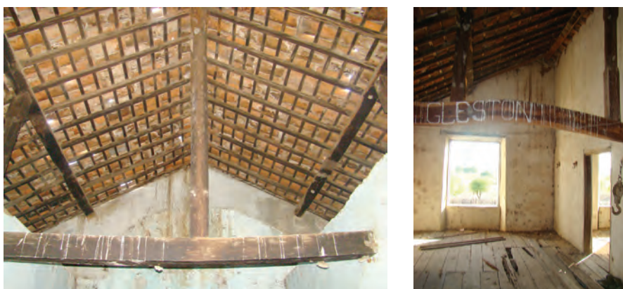
Figura 209: Estrutura de cobertura
