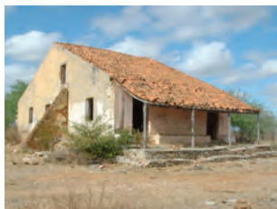
Figura 171: Casa da Fazenda Pitombeira Fonte: FEIJÓ, 2002.
