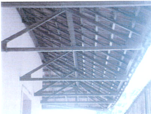
Vista da estrutura metálica de suporte da cobertura da varanda
