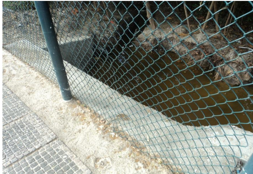
TRECHO DA GALERIA DE LANÇAMENTO DENTRO DO IGUATEMI
