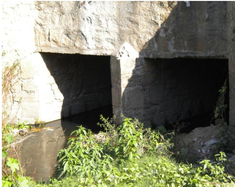
Galeria a Jusante
