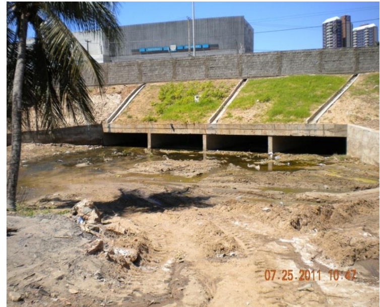
Galeria a Jusante
