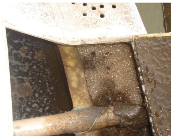
FIGURA 6.12 – Retorno de lodo decantado
