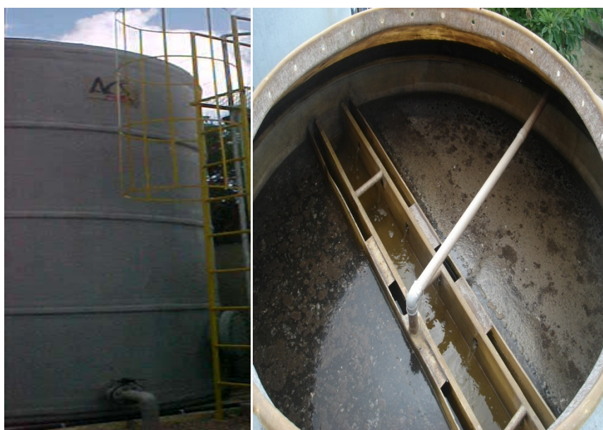
FIGURA 6.10 – Vista externa e interna do reator aeróbio.
