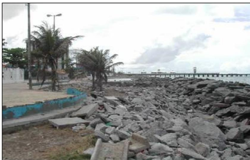
**Figura 74** – Intenso processo erosivo com muros de contenção de erosão na Praia de Iracema. Ao fundo a Ponte Metálica. **Fonte:** Fechine, julho de 2006
