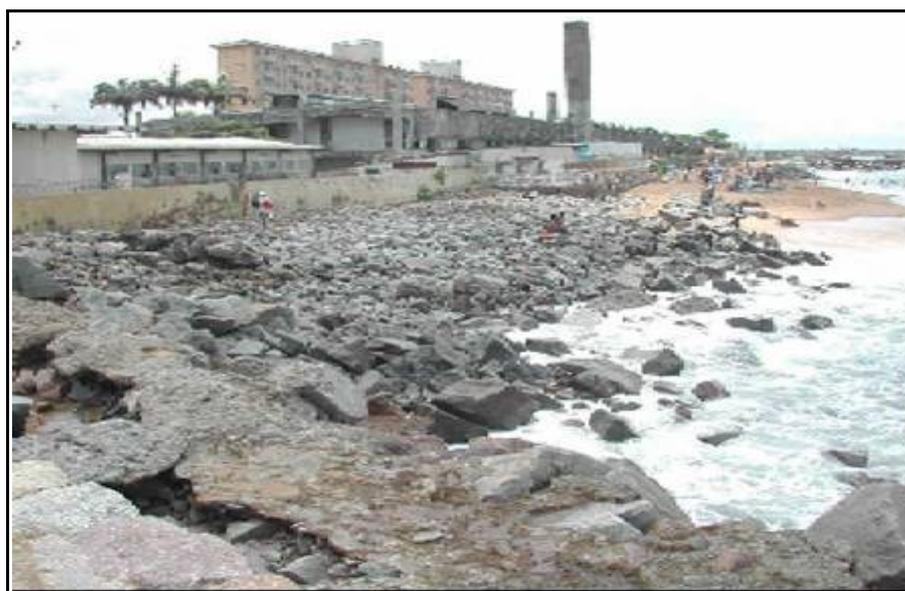
**Figura 77** - Intenso processo erosivo a oeste da Ponte Metálica com muros de contenção de erosão. **Fonte:** Fechine, julho de 2006
