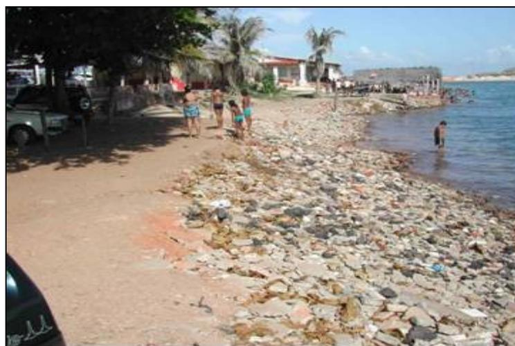
**Figura 51** - Aterro irregular na margem do rio Cocó, construído para proteger as barracas de praia de uma possível subida da maré sobre a foz do rio, evidenciando um processo de assoreamento da foz. **Fonte:** Fechine, agosto de 2006
