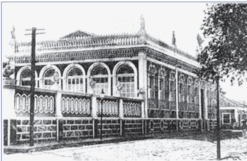
Fachada do Palacete Phenix Caixerial, lado ocidental na Rua Guilherme Rocha - 1905
