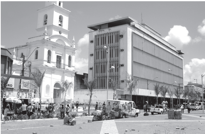
Local (hoje) onde ficava o Palacete da Fênix Caixeiral na esquina da Rua General Sampaio com Rua Guilherme Rocha
