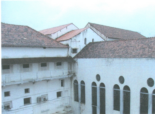
Vista coberta (telha cerâmica)
