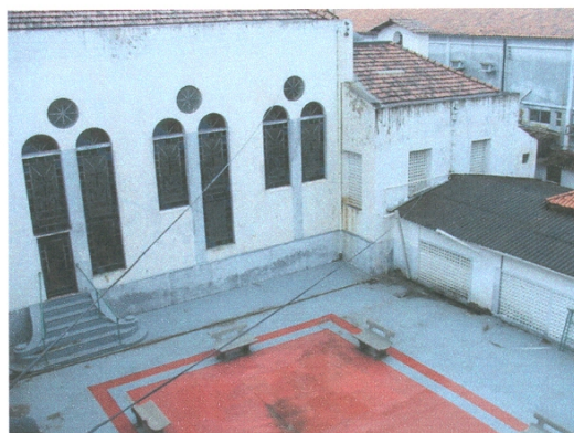
Vista fachada lateral da capela
