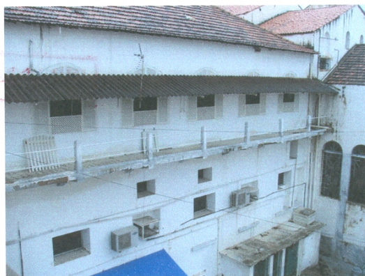
Vista fachada oeste (interior)
