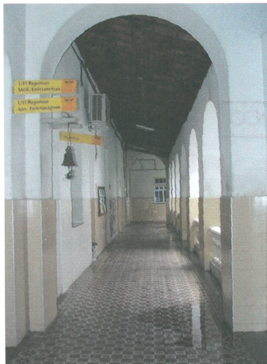
Vista acesso seção norte
