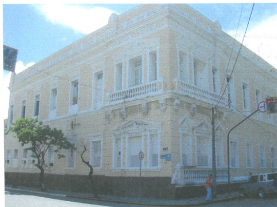
Vista fachada lateral sul (Rua Dr. João Moreira)
