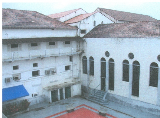
Vista fachada lateral da capela
