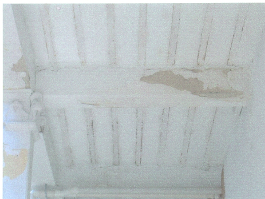
Vista laje (mista - tijolo e perfis metálicos)
