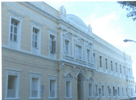
Vista fachada principal (Rua Barão do Rio Branco)
