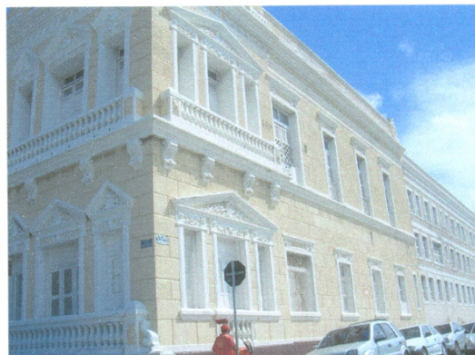
Vista fachada lateral norte (Rua Senador Jaguaribe)
