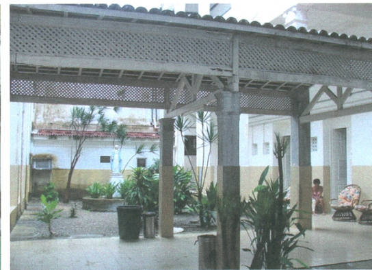
Vista pátio interno seção sul
