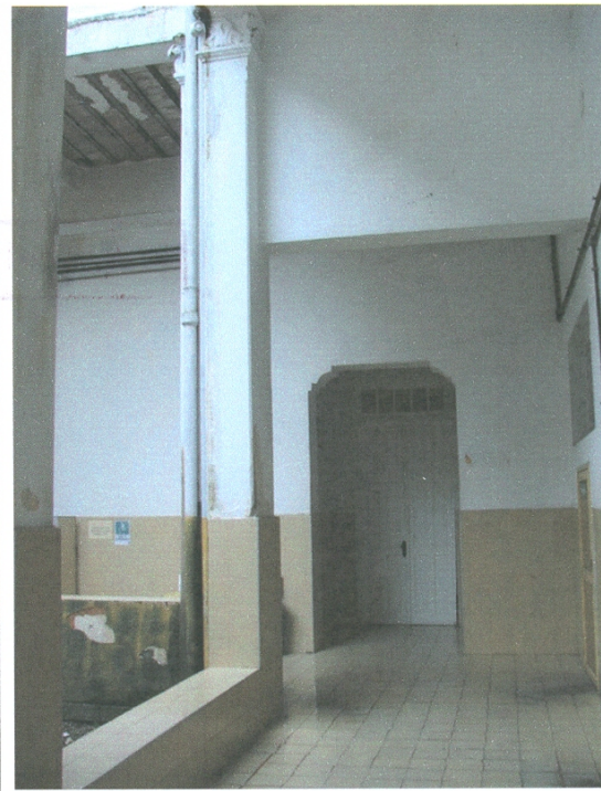
Vista acesso seção sul
