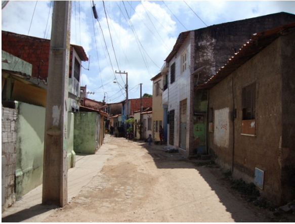
FIGURA 65. Poço da draga – habitações Fonte: Acervo próprio
