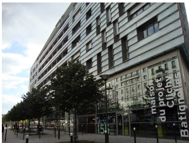
FIGURA 33. Escritório do aménageur da ZAC Fonte: Acervo próprio
