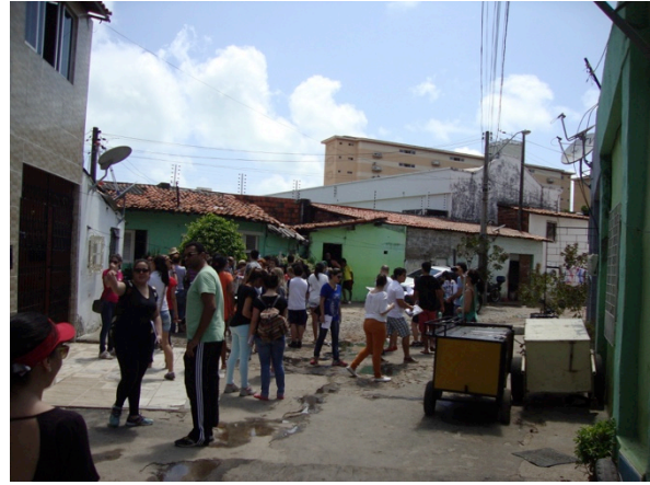
FIGURA 66. Poço da draga – falta de sistema de drenagem Fonte: Acervo próprio
