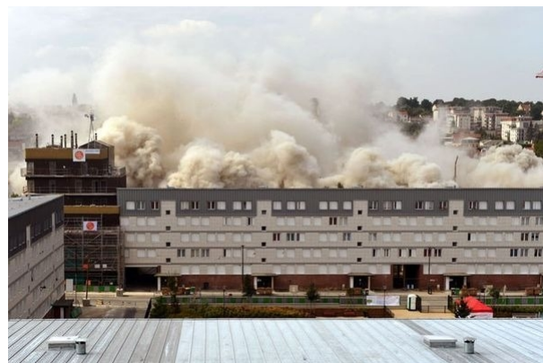
FIGURA 48. Demolição da última torre em Cité Balzac – depois Fonte: < http://www.franceinter.fr/emission-interception-vitry-sur-seine-le-roman-de-balzac >
