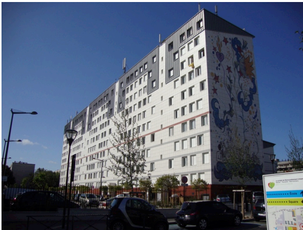
FIGURA 43. Requalificação de edifício antigo: residencialização e pintura da fachada Fonte: Acervo próprio
