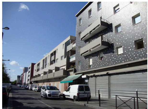
Figura 46. Novos edifícios de uso misto, com comércio no térreo Fonte: Acervo próprio
