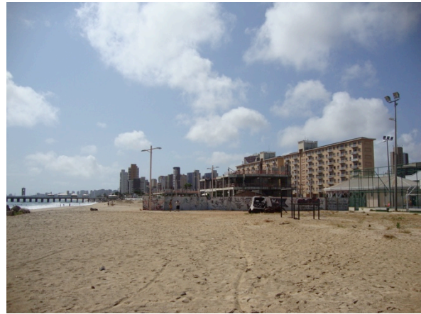
FIGURA 73. Obra do Acquário na faixa de praia Fonte: Acervo próprio
