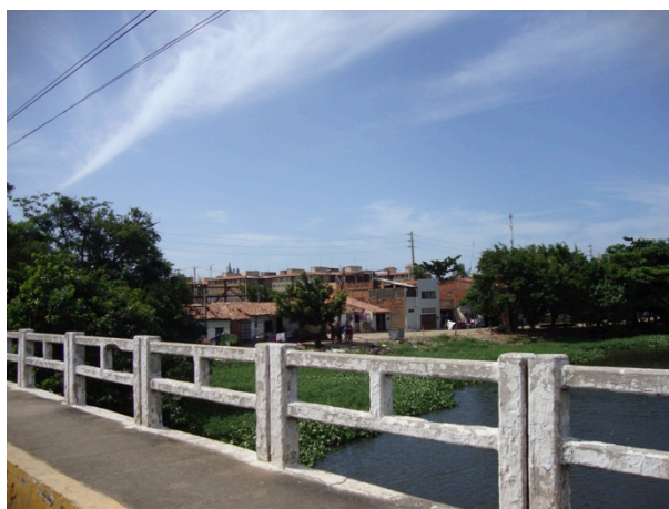
Figura 62. Conjunto de casas, fora da ZEIS do Lagamar, atingidas pelas obras dos viadutos e rotatória Fonte: Acervo próprio
