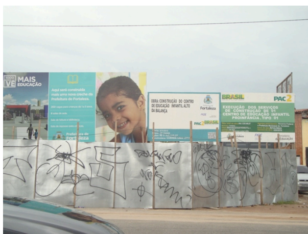
FIGURA 63. Obras de construção do Centro de Educação Infantil Alto da Balança Fonte: Acervo Próprio
