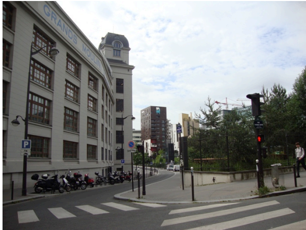
FIGURA 24. Grand Moulin à esquerda Fonte: Acervo próprio
